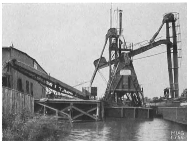
Abb. 94. Schwimmendes Becherwerk. Miag.
