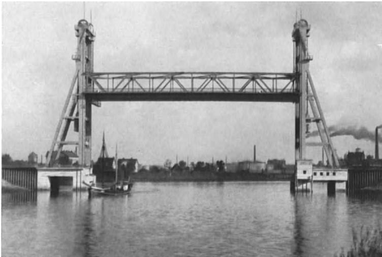
Abb. 132. Hubbrücke über die Rethe bei Hamburg.
