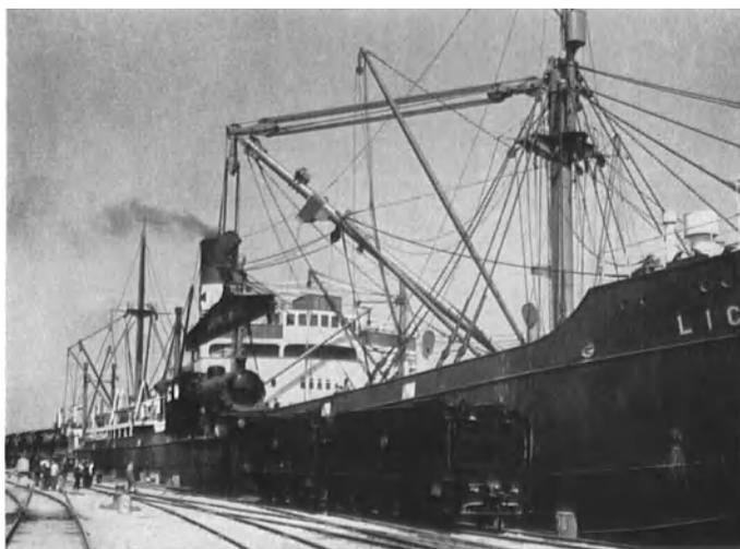
Abb. 53. Schwerlast-Ladebaum eines Seeschiffes.
