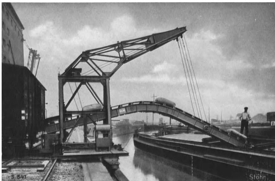
Abb. 57. Bandförderer zwischen Schiff und Eisenbahn. Stöhr.
