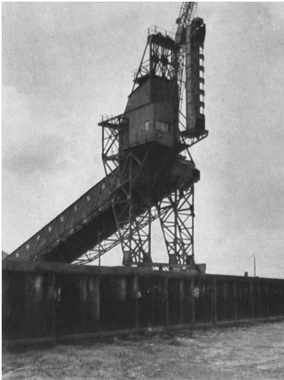
Abb. 109. Kohlenverladeanlage mit Förderband und Niedertragevorrichtung in einem Seehafen. (Blyth.)
