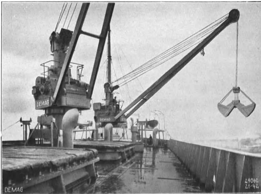
Abb. 56. Bordwippkrane für Greiferbetrieb. Demag.
