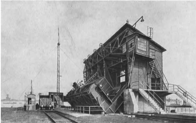
Abb. 88. Seitenkipper für Seeschiffsbeladung. Pohlig (Gedingen).
