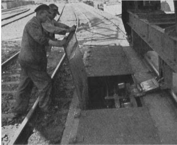
Abb. 27. Schlitzloser Schleifleitungskanal. P. Vahle, Dortmund.
