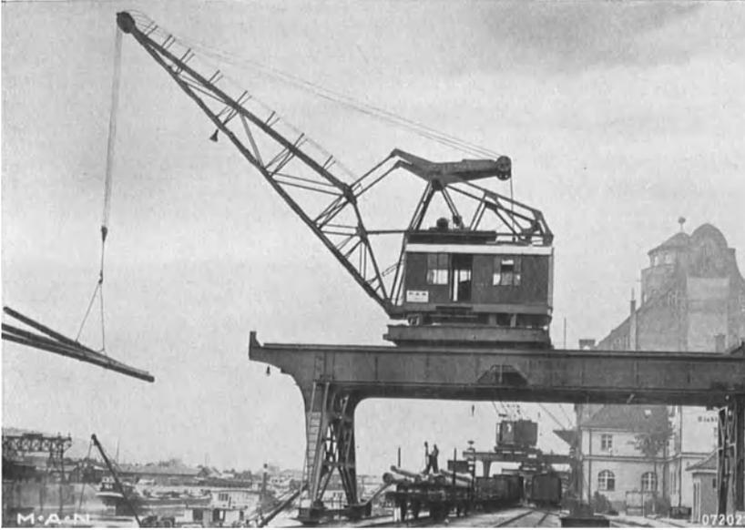
Abb. 42. Brückenkran mit Schwinghebel-Wippausleger, 4 t, 16 m. MAN (Aschaffenburg).
