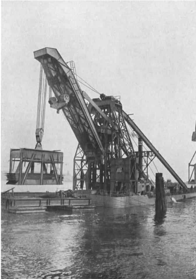
Abb. 16. Schwerlastschwimmkran 250 t (Manchester).
