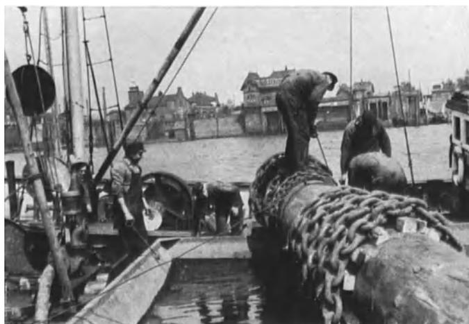
Abb. 14. Winde und Windenbaum beim Heben eines Wracks.
