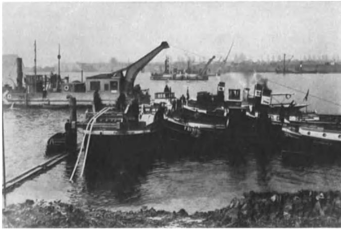
Abb. 10. Unterwasserkabelverlegung mit Baggerhilfe.
