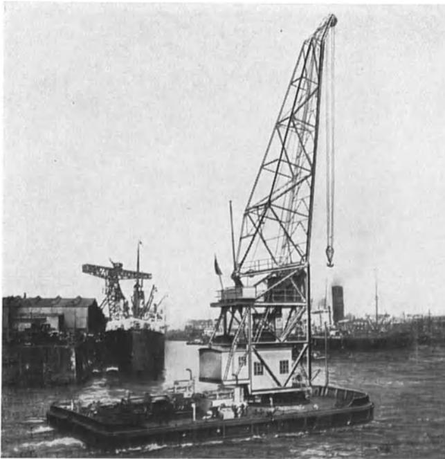
Abb. 46. Schwimmkran 30 t, 12 m. Kampnagel (Hamburg).
