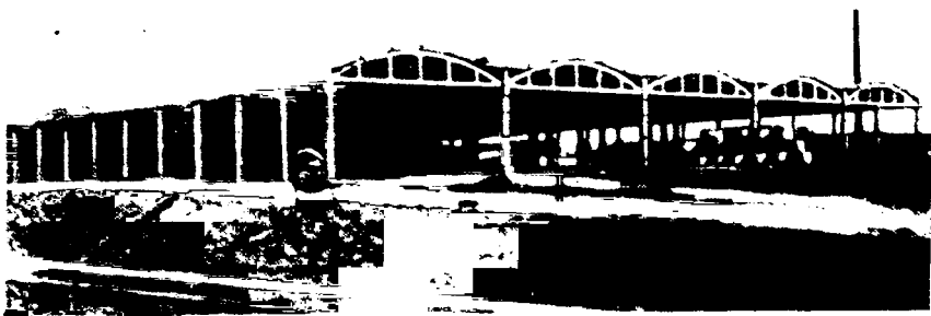
Рис 8.33 Строительство здания с безраскосными фермами в Литовской ССР
