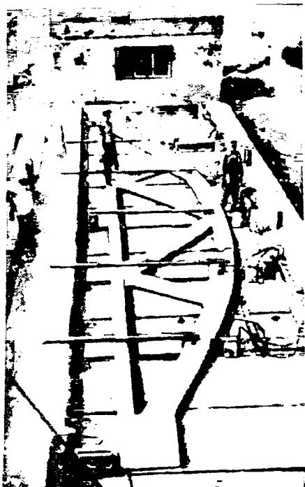
Рис. 13.6. Испытание одной фермы в горизонтальном положении на специальном горизонтальном стенде
