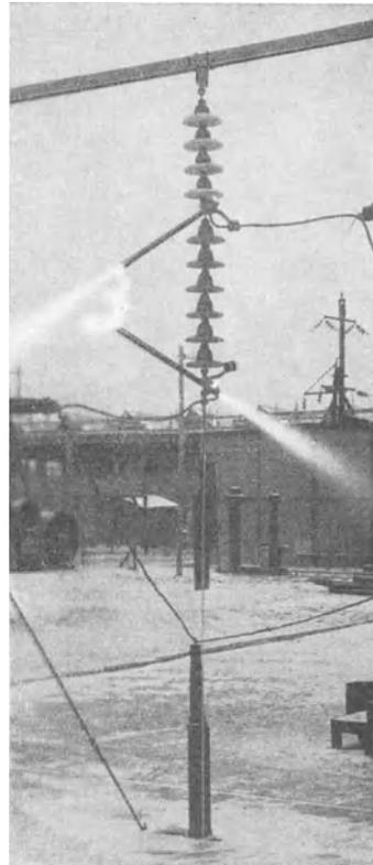
Abb. 362. Freileitungs-Löschrohrableiter beim Ansprechen.
