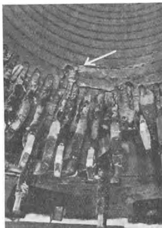
Abb. 323. Wicklungszerstörung durch Körperschluß (Erdschluß).
