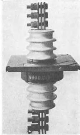
g) Schienen-Durchführungs-Stromwandler für Innenraum mit 2 Meßkernen, Reihe 30, 4000/5/5 A.
