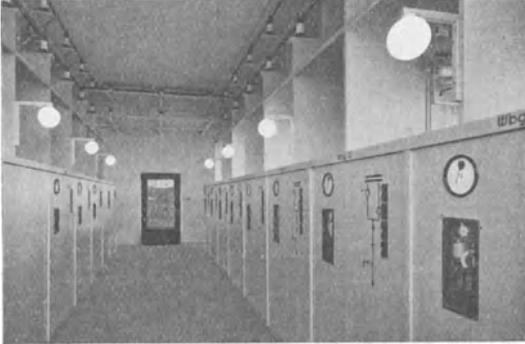
Abb. 458. Bedienungsgang einer 10-kV-Anlage, zweireihige Aufstellung, Hufeisen-Doppelsammelschienen in Dreieckanordnung, Lichtbogenschutz, Zellen-Blechplattenabschluß.
