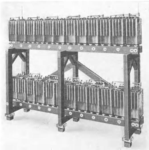
Abb. 56. Batteriezellen in Stockwerkaufstellung.
