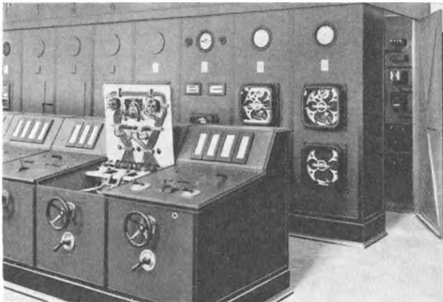
Abb. 426. Freistehendes Schaltpult geöffnet.
