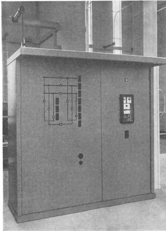
Abb. 467a. Steuer- und Schutzschrank für ein 100-kV-Kuppelfeld. Vorderseite.
