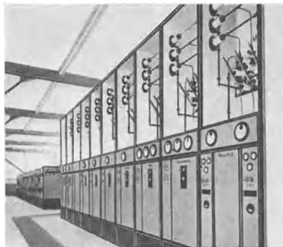
Abb. 454. 15-kV-Schaltzellen mit Doppelsammelschienen, Lichtbogenschutz durch Zellentrennwände (ältere Ausführung).
