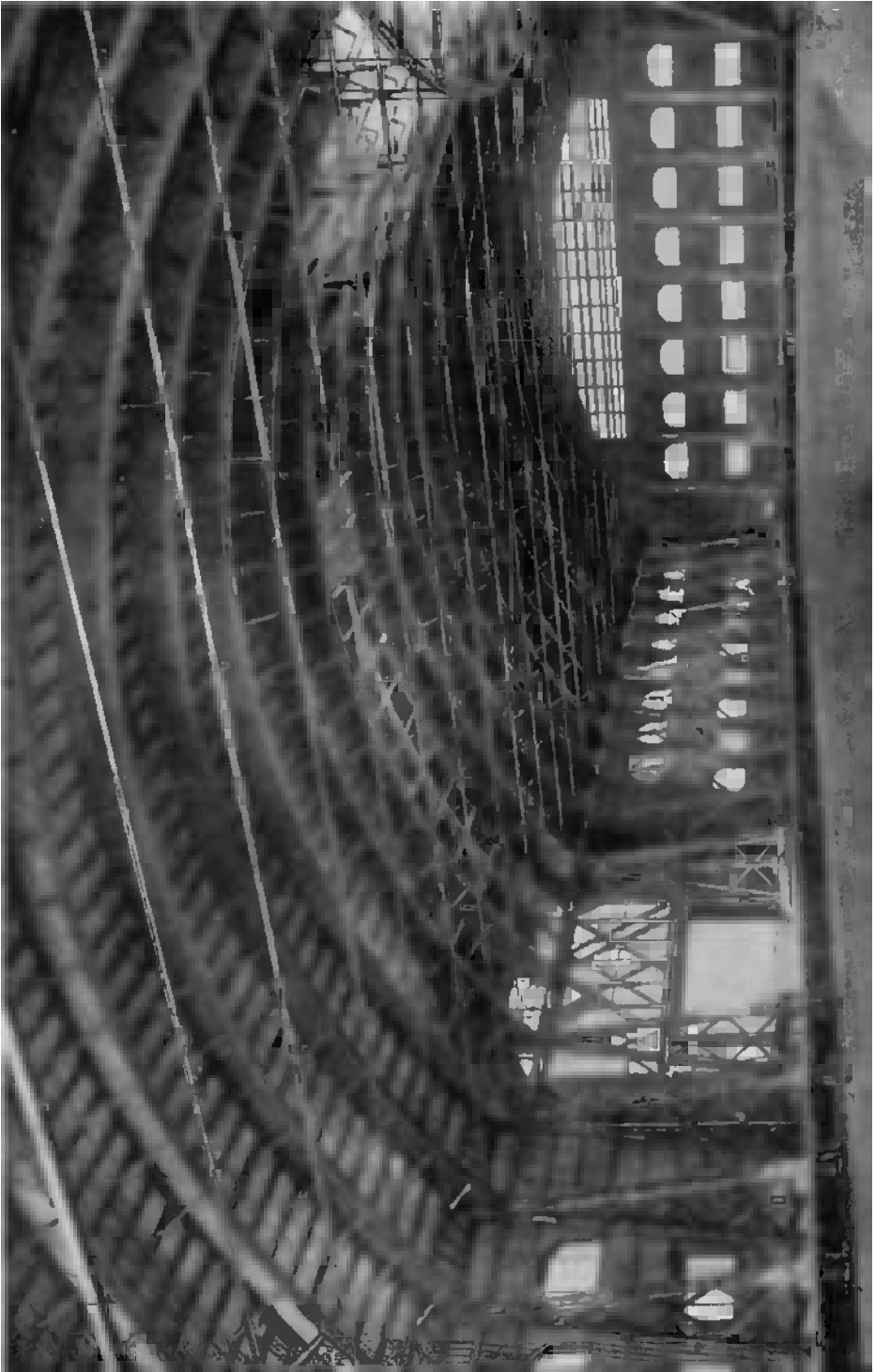
Abb. 5. Hafenhalle für Großflugzeuge. Innenansicht nach Fertigstellung. Binderspannweite 55 m; Stützenhöhe 18 m; Scheitelhöhe 31 m.
