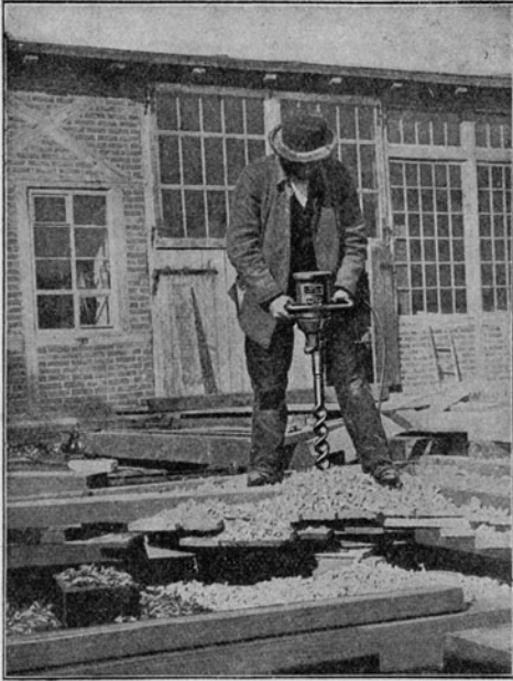
Abb. 27. Vertikalbohrung mit elektrisch betriebener Bohrmaschine der A. E. G.
