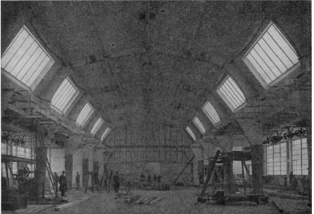
Abb. 15. Maschinenhalle in Olten (Schweiz).
