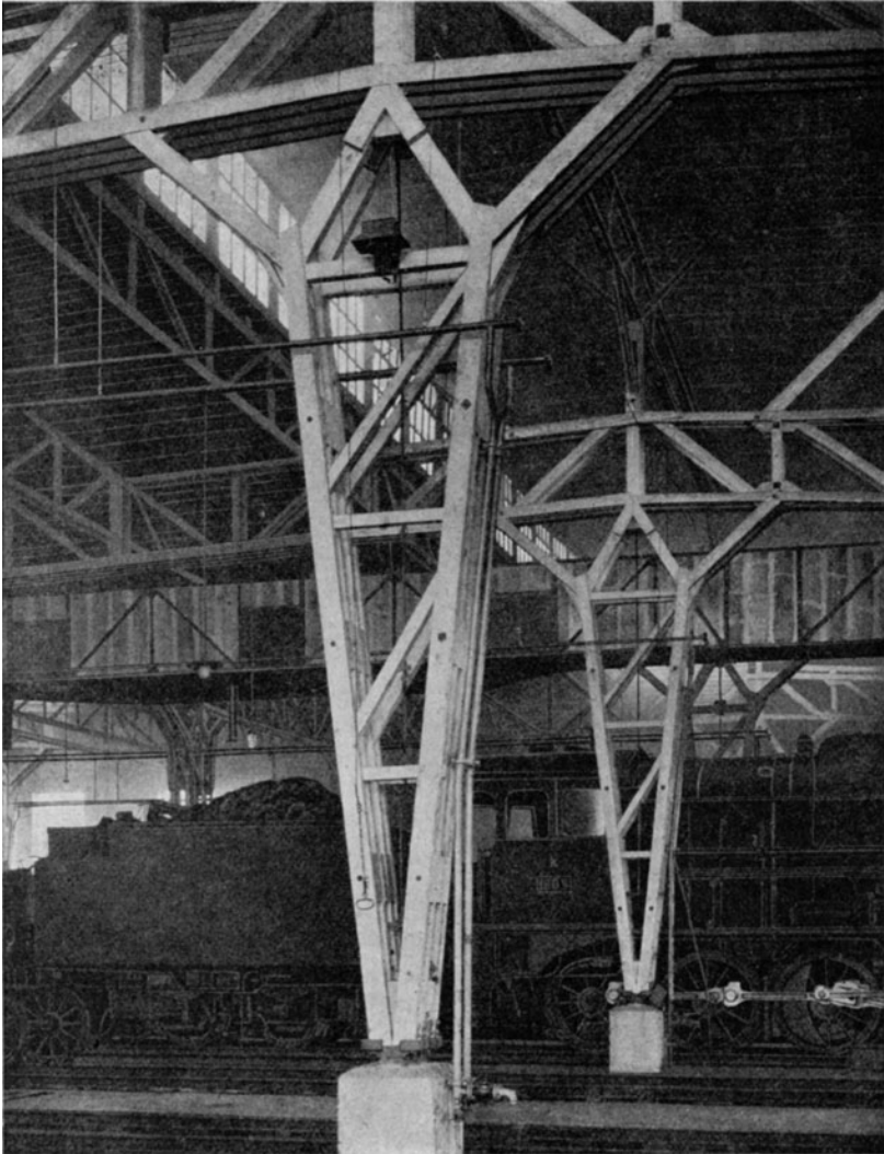
Abb. 24. Lokomotivschuppen; Mittelstützen der Seitenbinder (s. auch Abb. 34).
