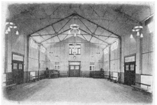
Abb. 1. Doecker-Turnhalle mit eisernen Fachwerksbindern, Stützweite 8—12,0 m.
