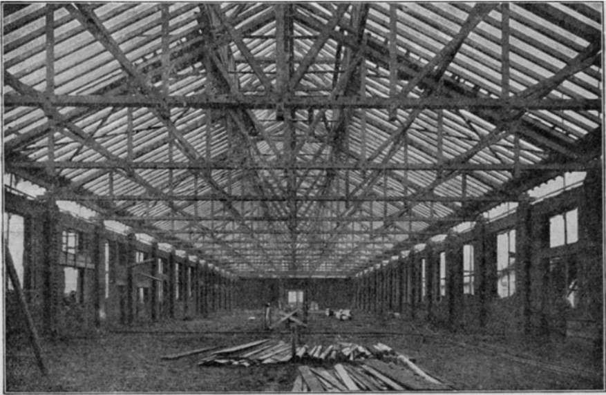
Abb. 25. Dreiecksförmiger Dachbinder von rd. 20 m Spannweite.
