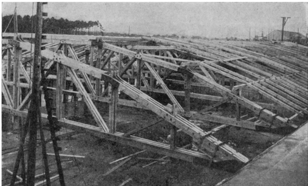
Abb. 35. Wagenreparaturhalle Waggonfabrik Niesky, Stützweite 28,6 m, ausgeführt 1919.
