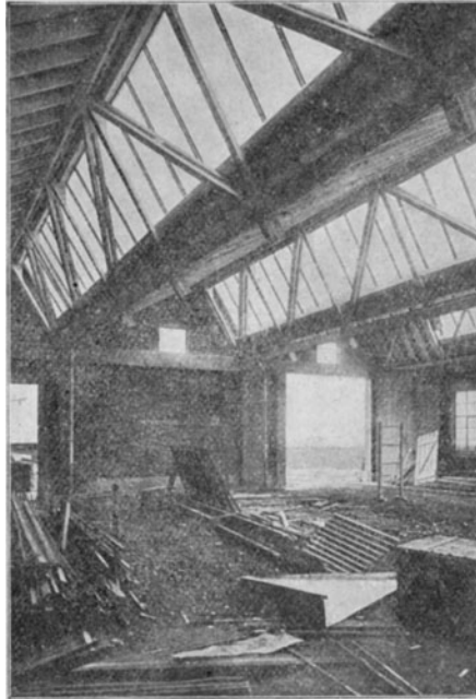
Abb. 34. Shedkonstruktion mittels Fachwerkbinder.
