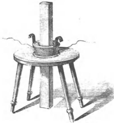
umgebende Multiplicatorrolle war noch von einer als Dämpfer wirkenden, aus wenigen Windungen starken Kupferdrahtes gebildeten Spule umschlossen; seine Schwingungen machte ein kleines Spiegelchen *a* mit, dessen Bewegungen durch ein Fernrohr *F* mittels der Skala *S S* zu beobachten sind, wie es Fig. 2 veranschaulicht. Der Zeichengeber enthielt eine Inductionsrolle, welche (in ähnlicher Weise, wie es Fig. 3 zeigt)
