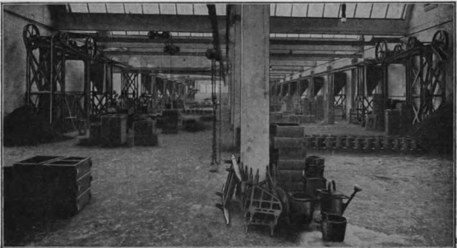
Abb. 220. Förderanlage und Behälter für Fertigsand.
