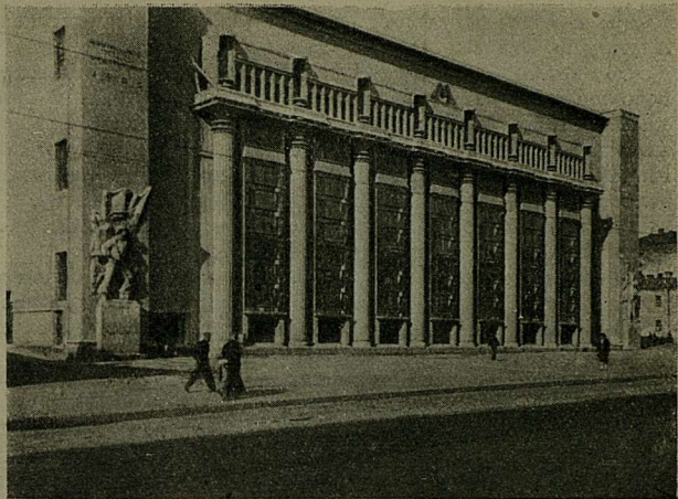
Электрическая подстанция метрополитена им. Л. М. Кагановича на улице Герцена.
