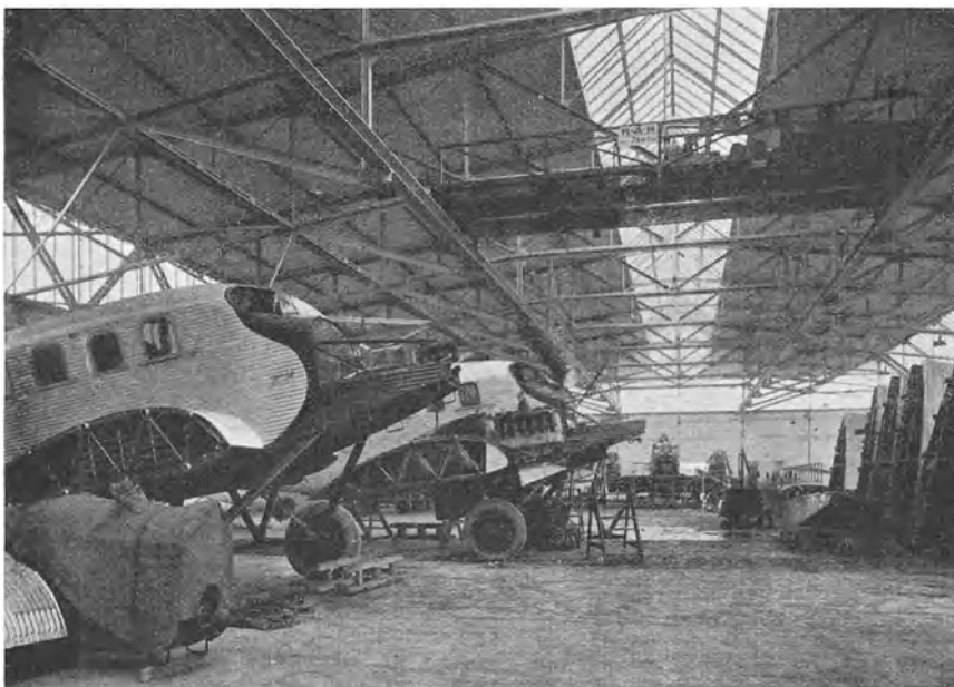
Abb. 63. Blick in die Fertigmontagehalle der Junkers-Flugzeugwerke, in welcher die Flugzeuge, die, um Raum zu sparen, in Teilen aufgestapelt sind, für den Start an ihren Bestimmungsort zusammengebaut werden.
