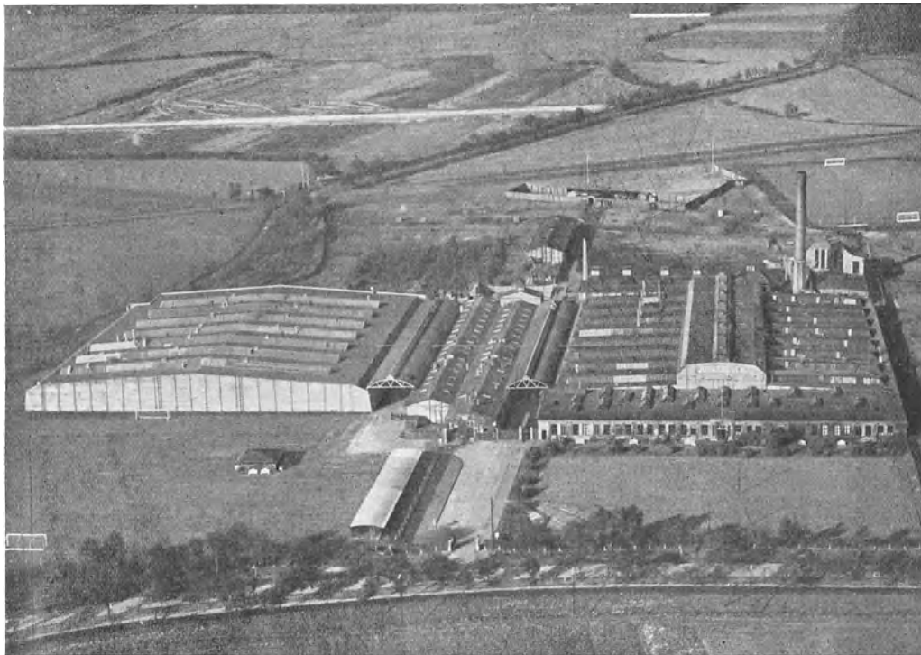
Abb. 14. Junkers & Co., Dessau, Fabrik für Warmwasser-Apparate.
