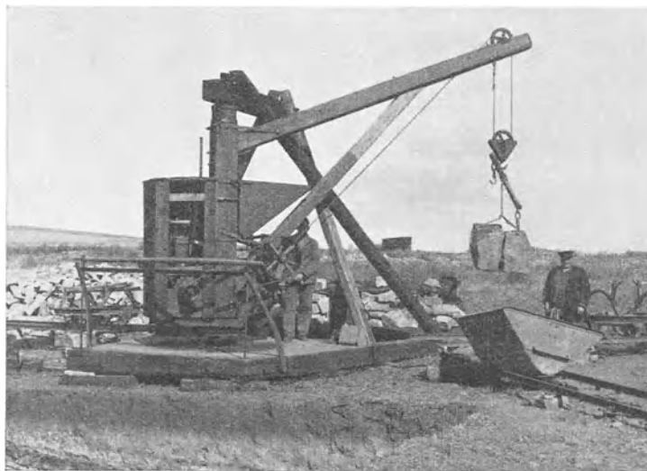
Abb. 7. 8 PSe Junkers-Motor, eingebaut in einen primitiven Drehkran.
