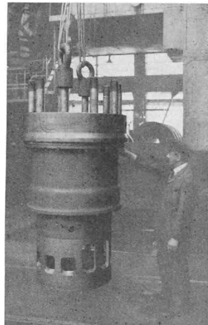
Abb. 26. Obere Laufbüchse mit Kühlmantel.
