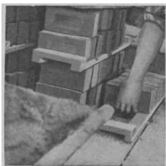
Fig. 6. Ziegel von den unteren Packen müssen so abgenommen werden.
