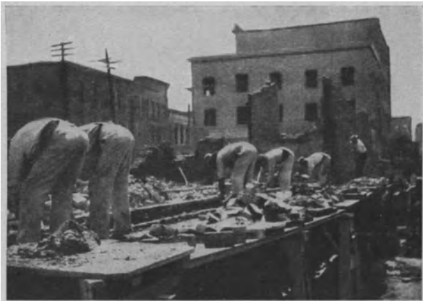
Fig. 20. Gewöhnliches Bockgerüst. [In dieser Stellung können die Maurer selbstverständlich weniger leisten, als wenn sie sich nicht bücken müßten.
