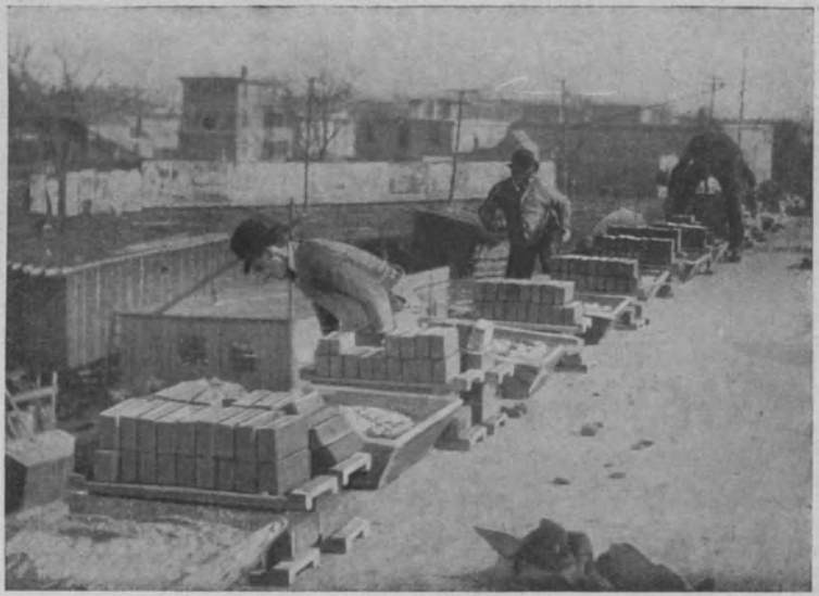
Fig. 10. Richtige Anordnung von Ziegelpacken und Mörtelschaff bei Untergrundmauern. Die Ziegelpacken müssen in diesem Fall niedrig sein.
