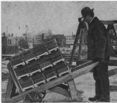
Fig. 17. Zweiräderiger Handkarren zum Transport von 12 Ziegelpacken. Das Modell ist so ausbalanciert, daß mit weniger Anstrengung mehr gehoben werden kann als mit gewöhnlichem Schubkarren.
