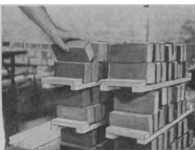
Fig. 5. So dürfen die Ziegel nicht von den oberen Packen abgenommen werden.
