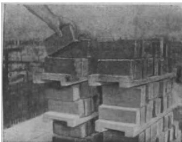
Fig. 4. So müssen die Ziegel von den oberen Packen abgenommen werden.
