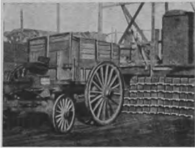
Fig. 15. Z w e i gespann, das zweckmäßigste Beförderungsmittel für Ziegel vom Verladeplatz zur Baustelle. Die Pferde warten nicht auf die Be- oder Entladung, sondern holen stets neue Wagen.
