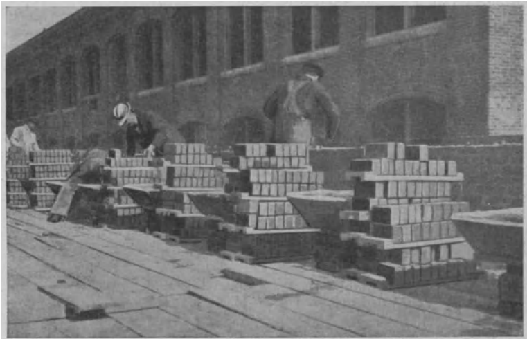
Fig. 11. Richtige Anordnung von Ziegelpacken und Mörtelschaff bei halbmannshohen Mauern. Die Ziegelpacken müssen in diesem Fall hoch sein und die Schaffs erhöht stehen.
