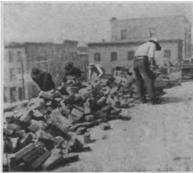
Fig. 9. So unzweckmäßig wird in der Regel dem Maurer das Material zugestellt.
