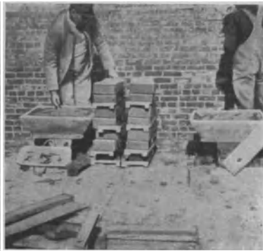
Fig. 12. Richtige Anordnung von Ziegelpacken und Mörtelschaff bei schulterhohen Mauern, wenn jeder Ziegel einzeln eingemörtelt wird.
