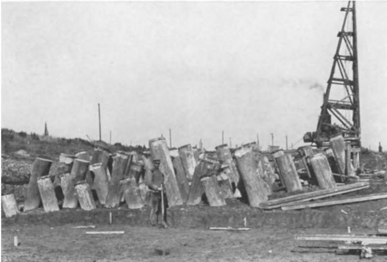
Abb. 124. Infolge Rammung aufgetriebener Kleiboden.
