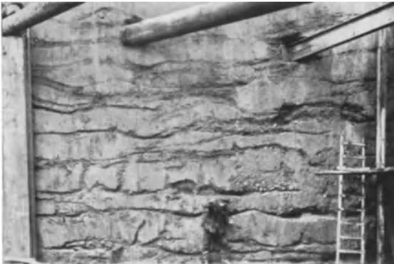
Abb. 150. Zustand des Unterwasserschüttbetons einer Trichterschüttung.
