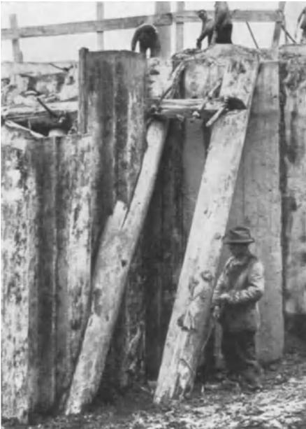
Abb. 92. Durchrammung eines Pfahlrostbauwerkes durch Stahlsplundwände.
