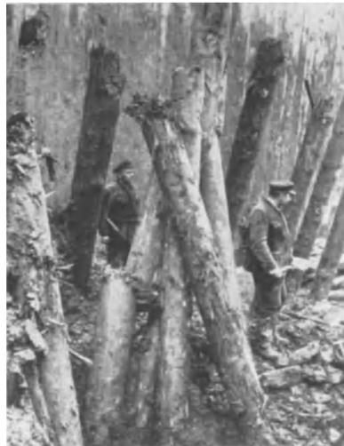
Abb. 135. Lage der Pfähle bei einem freigelegten Pfahlrost.
