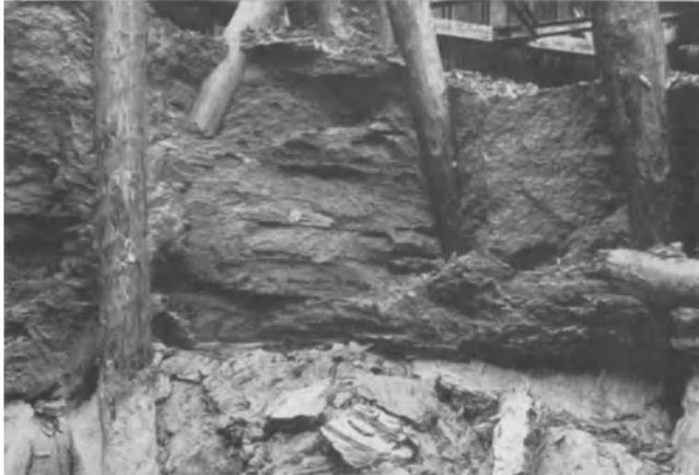
Abb. 136. Durch Kleiboden gerammte Holzpfähle (geringe Veränderung des Bodengefüges).
