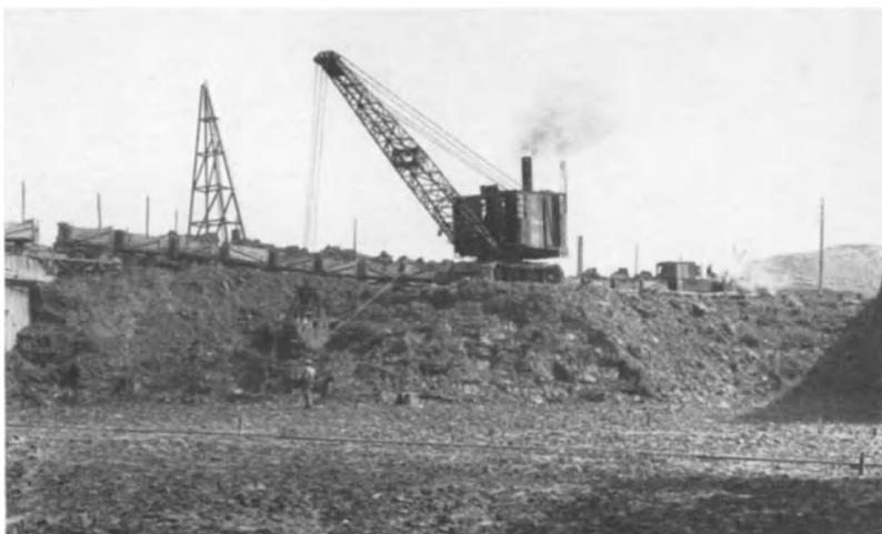
Abb. 50. Bodenaushub an 4–5 m hoher bindiger Böschung unter 60°.
