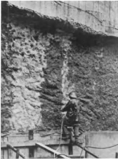
Abb. 151. Wasserdurchlässigkeit von Unterwasserschüttbeton.
