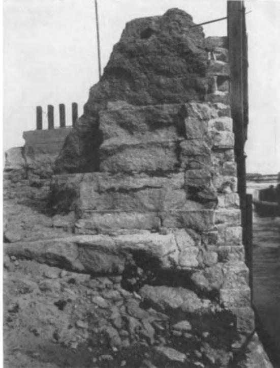
Abb. 147. Stampfbeton und Verblendung eines Stützbauwerkes.
