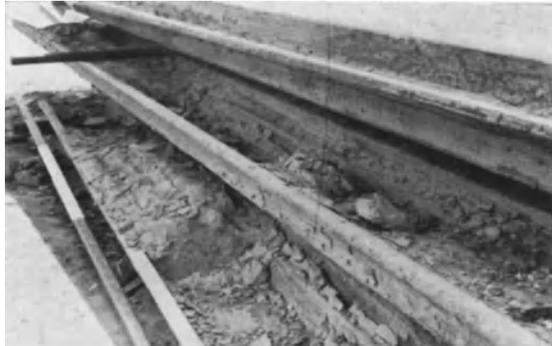
Abb. 56. In die Wandungen einer Spundwand infolge des Rammvorganges eingepreßter Boden.
