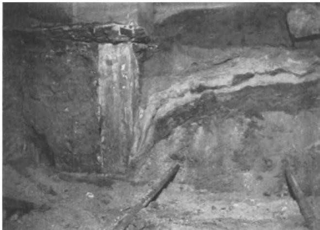
Abb. 137. Mitziehen des Bodens beim Rammen eines Eisenbetonpfahles.
