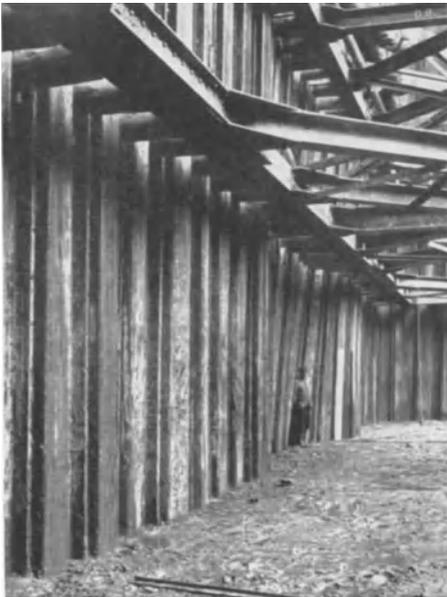
Abb. 89. Ausbuchtungen im unteren Viertel einer Stahlspundwand bei einer Baugrubeneinfassung.
