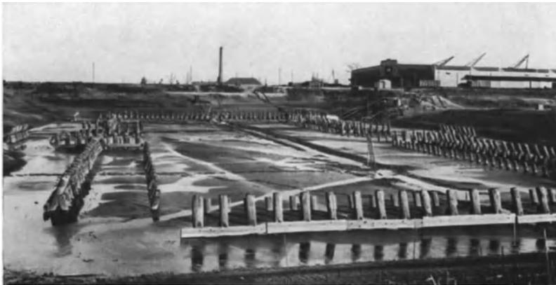
Abb. 46. Trockengelegte Baugrube im bindigen Boden.
