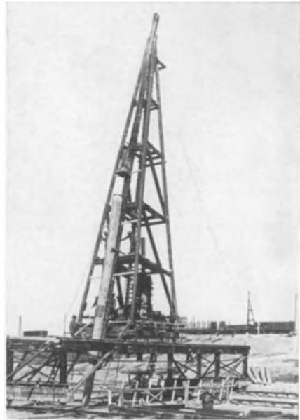
Abb. 134. Rammung eines Holzpfahles.
