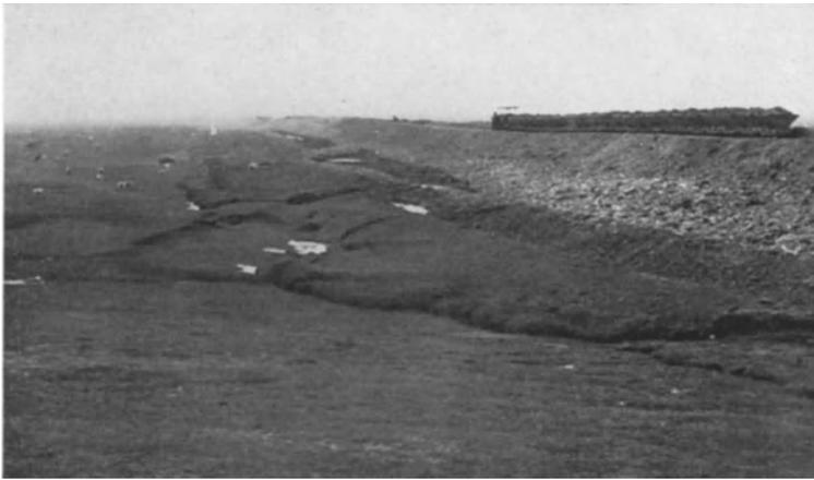
Abb. 51. Seitlich ausgewichener Boden bei einer Dammschüttung.
