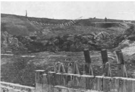
Abb. 54. Rutschung an einer Kleikippe von 6 m Höhe.
