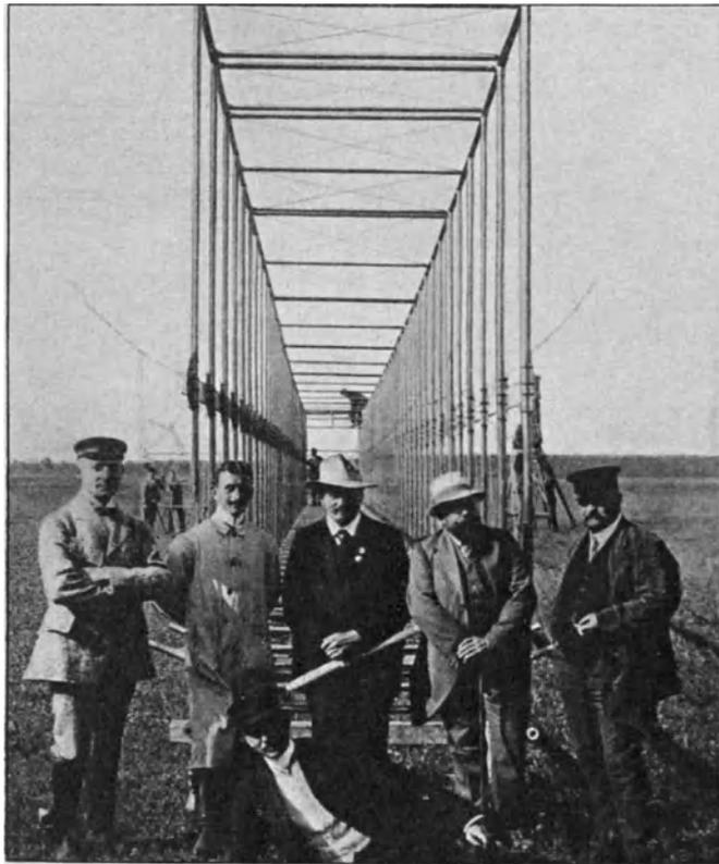
Fig. 15. Laufgang des Luftschiffes Veeh I.
