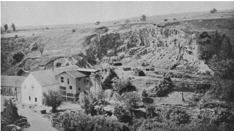
Abb. 417. Günstige Lage eines Steinbruches am Fuße eines Steilhanges. Granitwerke Limberg (N.-Ö.), Ing. R. Hen gl. Unmittelbarer Gesteinsturz in die Schotterquetsche und von hier auf die Abfuhrwägen
