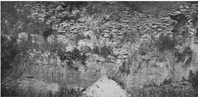
Abb. 409. Verrunden von Bruchstein einer Stützmauer; darunter anstehender Lithothamnienkalk. Steinbruch nächst Zogelsdorf (N.-Ö.)
