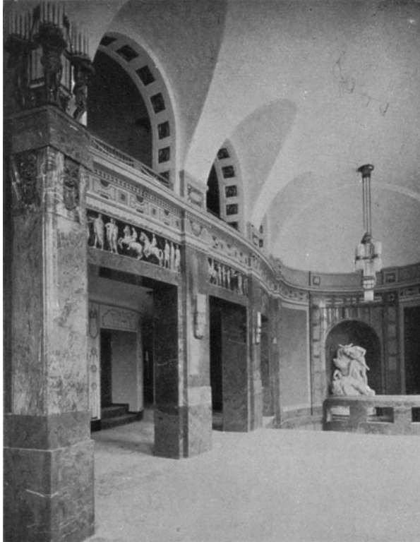
Abb. 402. Stadttheater in Chemnitz. Pfeilerverkleidungen von den Werken G. Taussig, Bayer. Marmorwerke, Bd. Aibling, Oberbayern
