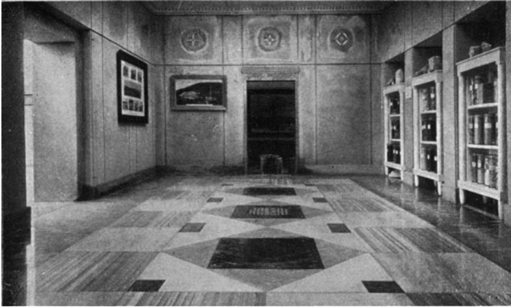
Abb. 403. Fliesenbelag. Rohstoff: Verschiedene schlesische Marmore der Werke W. Thust, Gr.-Kunzendorf, Kr. Neisse, Schlesien
