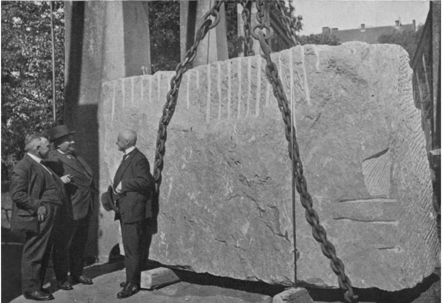
Abb. 268. Lahnmarmor-Rohblock aus den Marmorbrüchen der Firma G. Joerissen, G. m. b. H., Weilburg (Lahn) — im Ausmaß von 330 × 215 × 115 cm und einem Gewicht von 26.000 kg —, aus dem die Löwenfigur des Hochhauses in Düsseldorf gearbeitet wurde.
