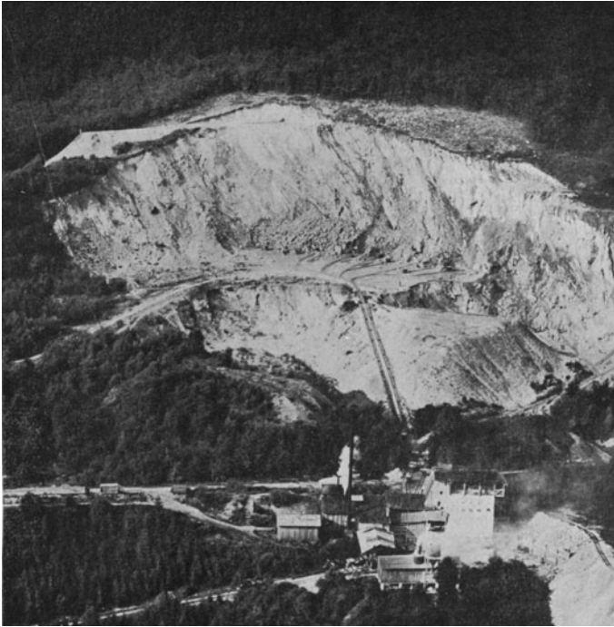
Abb. 413. Anordnung von Steinbruch, Förderanlage, Aufbereitung usw. Taunus-Quarzitwerke Köppern A. G., Bad Homburg a. d. Höhe
