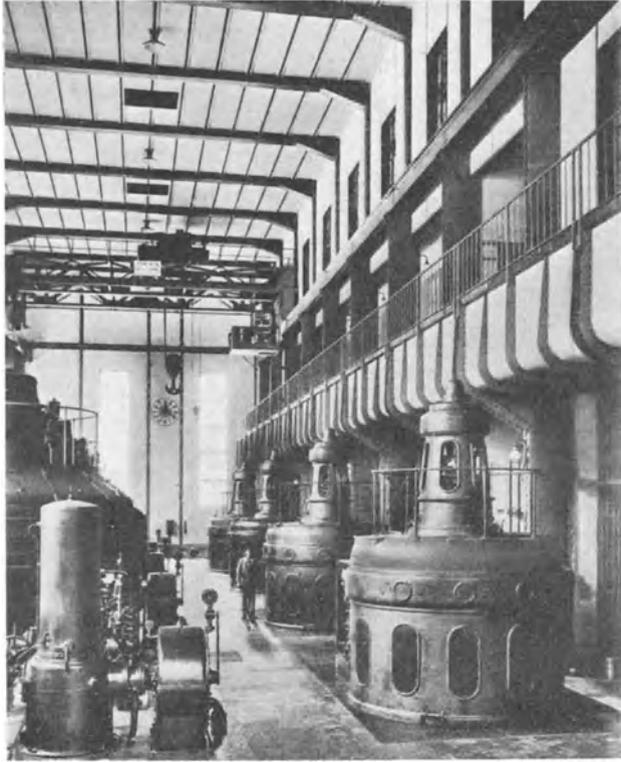
Abb. 55. 4 Stück Synchron-Induktionsmotoren für je 5500 PS Leistung bei  $\cos \varphi = 0,8$  vorliegend, 8400 Volt Spannung, 750 Touren pro Minute und 50 Perioden der Maschinenfabrik Oerlikon (Kraftwerk Wägital, Schweiz).
