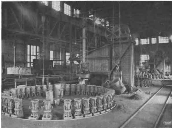
Abb. 62. Gießerei für Glattrohre (A. Hering A.G., Nürnberg).
