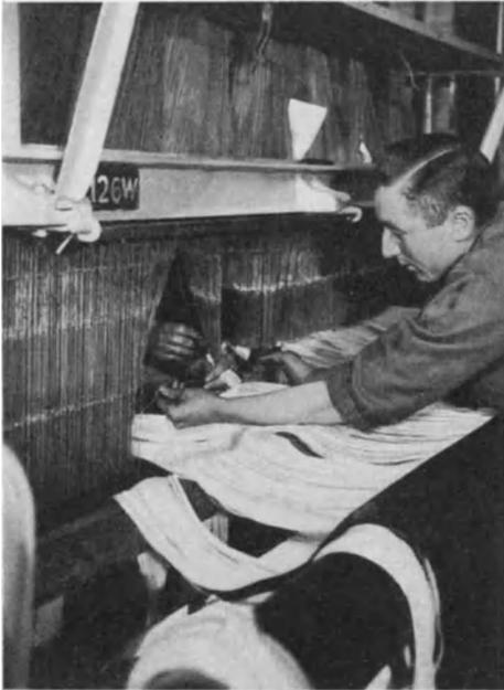
Abb. 79. Einziehen der Kettenfäden in den Harnisch.
