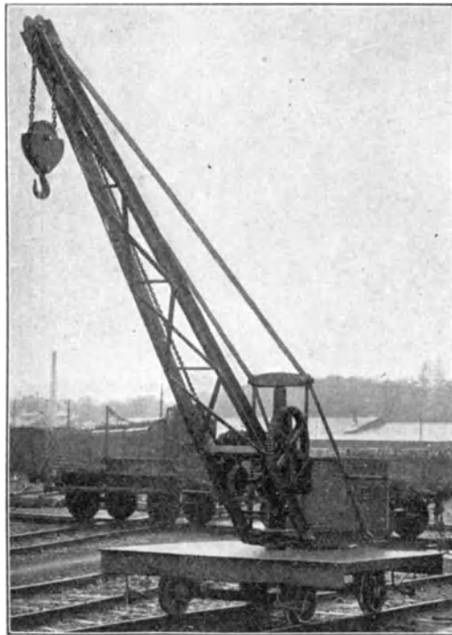
Abb. 71; Fahrbarer Drehkran, 4·7 m Ausladung, 3 t. Zobel, Neubert &amp; Co., Schmalkalden.
