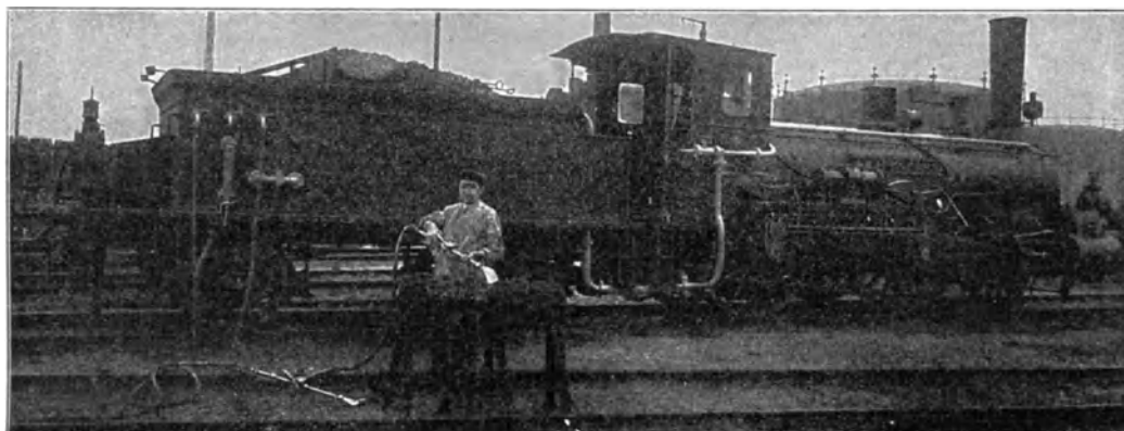
Abb. 13. Entstäubungsanlage in Ludwigshafen.
