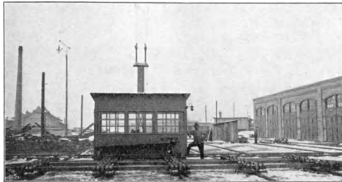
Abb. 51. Unversenkte Wagenschiebebühne. Ver. Maschinenfabrik Augsburg-Nürnberg.
