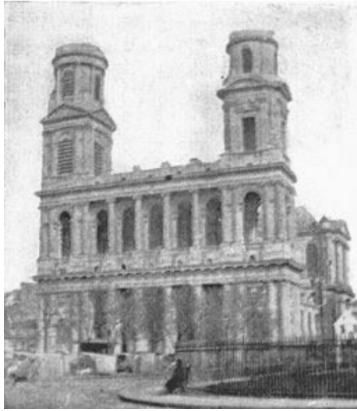
FIG. 183.—FAÇADE OF ST. SULPICE, PARIS.
