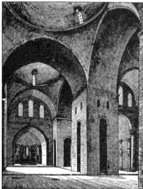
FIG. 95.—INTERIOR OF ST. FRONT, PERIGUEUX.
