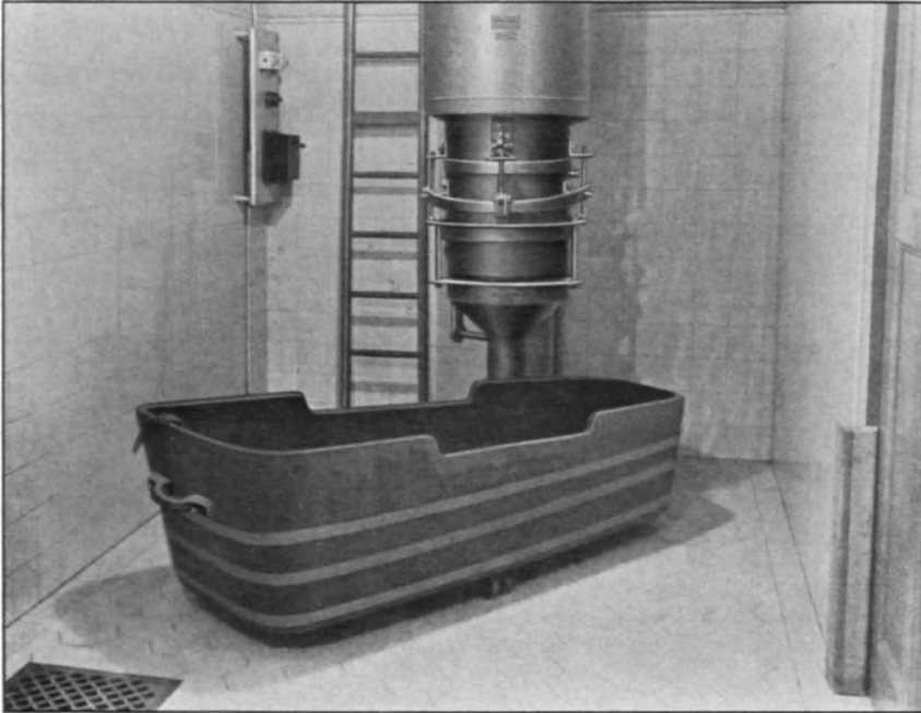
Fig. 45. Sandbadewanne mit Erwärmungsvorrichtung für den Sand (Virchow-Krankenhaus; System Bolte u. Loppow, Hamburg).
