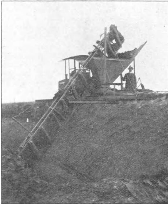
Abb. 16. Torfbagger Bauart Dr. Wieland.
