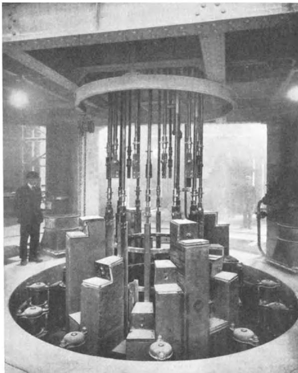
Abb. 136. Aufhängung der Miguet-Dauerelektrode.
