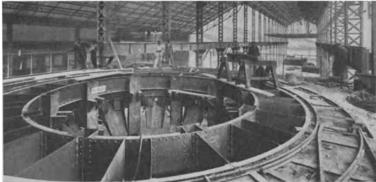
Abb. 178. Beschickungsvorrichtung eines Miguet-Ofens während des Einbaus.
