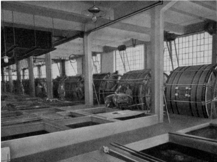
Abb. 159. Farbenwerkstatt und Gerbfäßanlage (Bad. Maschinenfabrik Durlach).
