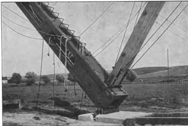
Fig. 102. Antennenträger mit Hilfsmast durch ein Gelenk verbunden.
