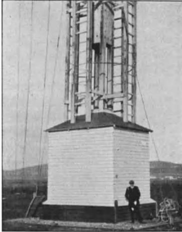
Fig. 104. Verkleidung des Mastfußes.
