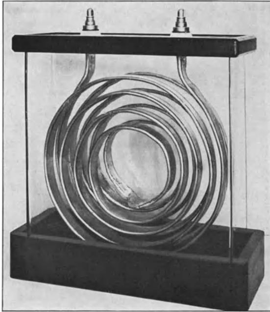
Fig. 24. Spiralspule in Öl für Sendezwecke.
