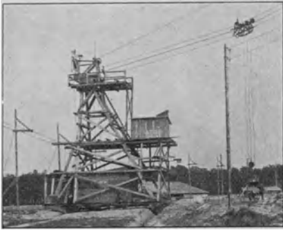
Fig. 71. Seitenansicht eines fahrbaren Turmes.
