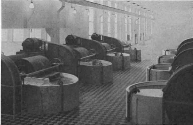
Abb. 48. Mahlholländer der Füllnerwerke G.m.b.H., Bad Warmbrunn (Schlesien).
