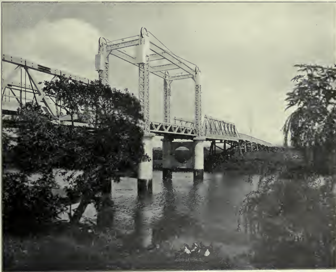
Hinton Bridge, N.S.W.
