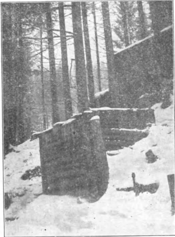
und greifen mit diesen ebenen Flächen über den Pfeiler, wobei die horizontalen Stämme einer Wand die kürzeren senkrecht zu ihr stehenden der anderen decken. Beide Wände sind am Pfeiler mit starken Nägeln festzunageln. Diese Bauten sind relativ einfach auszuführen und sehen dabei gefällig aus, erfordern aber saubere Arbeit, besonders beim Absägen und Ebnen der Enden. Falls kräftige Nägel vorhanden sind, werden die Häuser fest und dauerhaft.
