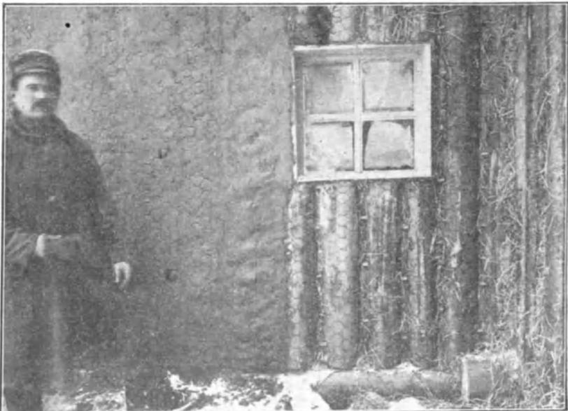
Die Nagelung letzterer erfolgt dann vom horizontalen zum senkrechten Rundholz in schräger Richtung. (Abb. 17 und 18.)
