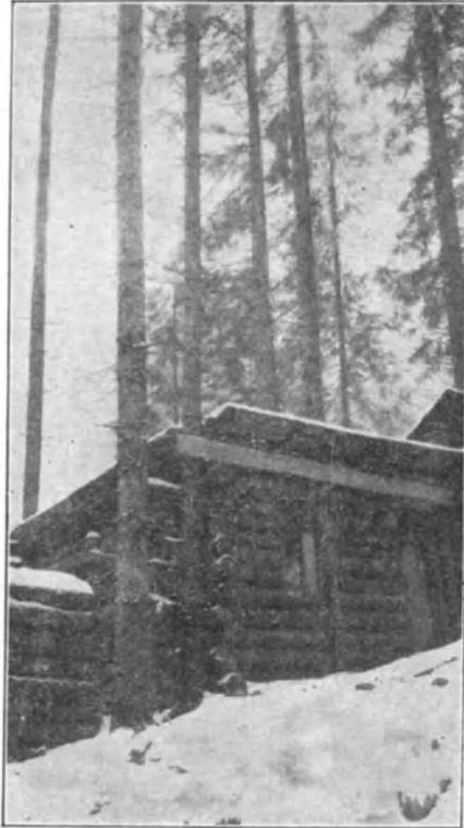
Falsch ist es auch lebende Bäume als Eckpfeiler zu verwenden. Jede stärkere Luftbewegung machen selbst starke Baumstämme mit und erschüttern dadurch das Gebäude. Abdichtungen fallen aus den Fugen, ja das ganze Haus kann einstürzen, wenn z. B. der Giebel des Baues an einen Baum gelehnt ist. Vgl. Abb. 13 und 14.
