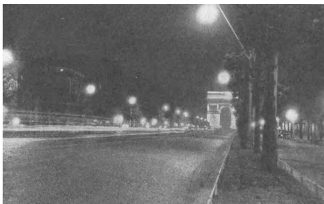
Abb. 2. Paris. Rue des Champs Elysées. Beleuchtung der Fahrbahn durch zweireihige seitliche Leuchten.
