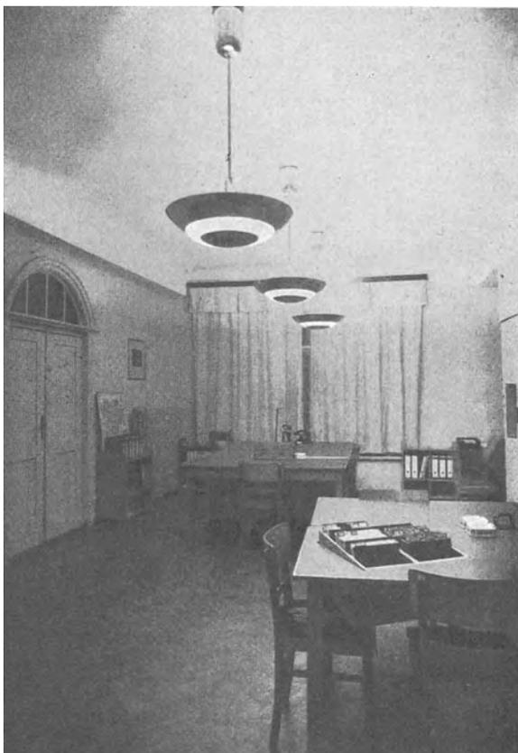
Abb. 6. Künstliches Tageslicht in einem Büroraum durch Mischlichtbeleuchtung. Leuchtenbestückung: 1 HgQ 300 + 4 Glühlampen je 60 W.
