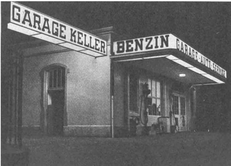
Abb. 1. Leuchtschilder mit Natriumdampflampen. Gesamtleistungsaufnahme 1260 W.
