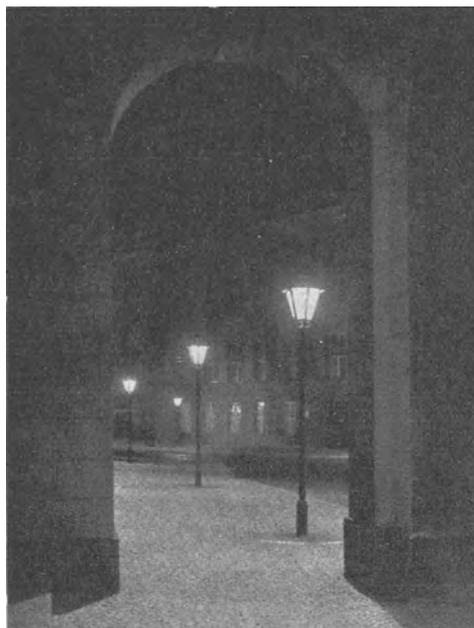
Abb. 6. Niedrige Masten an den beiden Straßenseiten. Unzureichende Beleuchtung des Fahrdammes.
