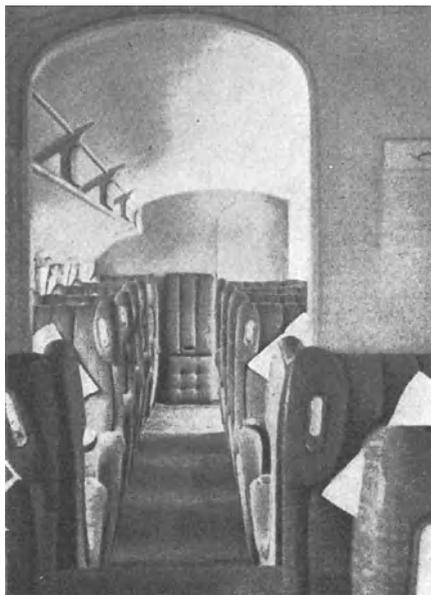
Abb. 5. Leuchten zur Allgemeinbeleuchtung in Gepäcknetzstützen, Leseleuchten in Ohrlehnen eingebaut.
