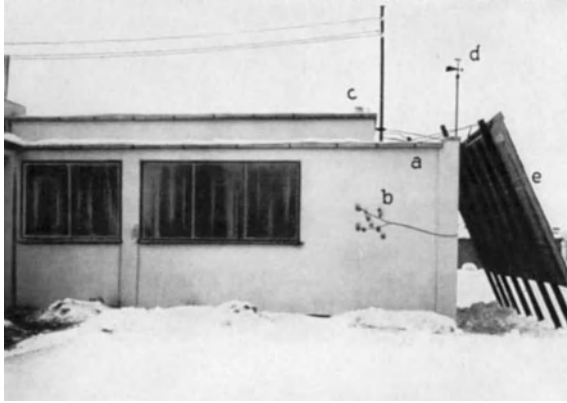
Abb. 34. Messung des Wärmeschutzes einer Hauswand. a Versuchswand, b Thermoelement, c Thermograph, d Windmesser, e Sonnenstrahlungsschutz.
