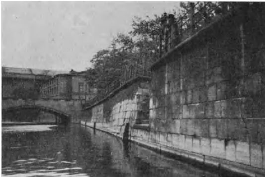
Abb. 88. Ufermauer im Lustgarten.
