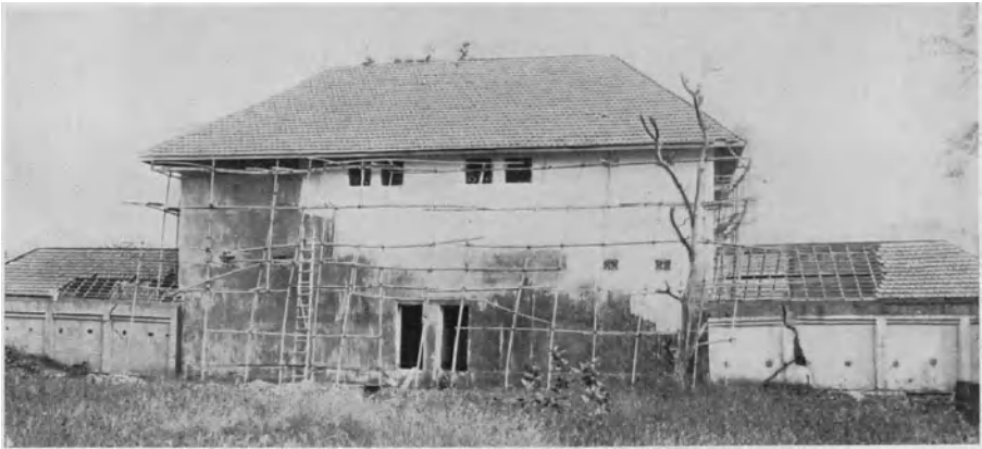
Abb. 79. Abreißen leichterer Anbauten vom Hauptgebäude infolge geringerer Setzung.
