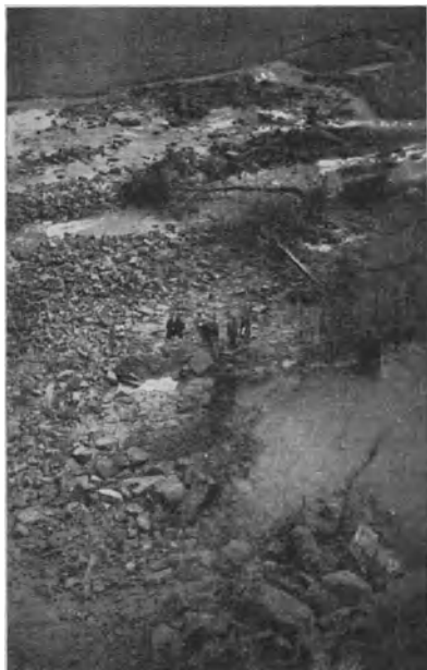
Abb. 60. Blick auf die in Abb. 59 im Querschnitt dargestellte Rutschung.
