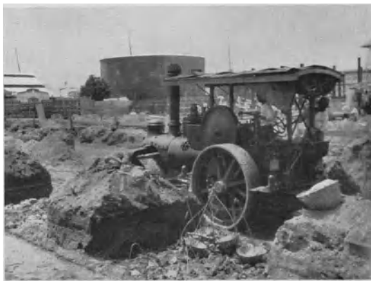
Abb. 82. Eine 8-t-Walze beim Einwalzen einer Lage Kalkschotter unter den Fundamenten eines Kaischuppens (Soerabaya, Java).
