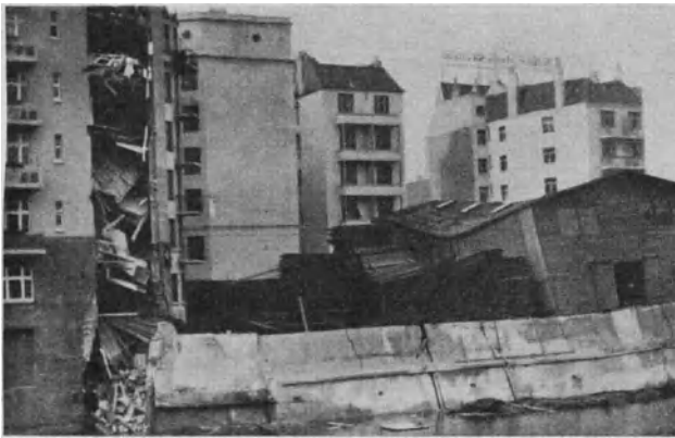
Abb. 89. Hauseinsturz in Hamburg.
