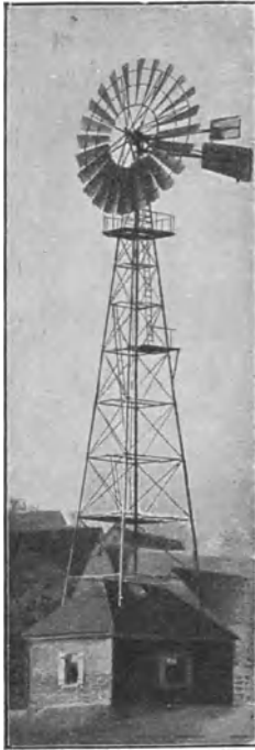
Fig. 29. Windmotor von 7\frac{1}{2} m Raddurchmesser auf 26 m hohem Eisenturm für eine Wasser-versorgungsanlage, Ausführung der Vereinigten Windturbinen-Werke G. m. b. H., Dresden-Niedersedlitz.
