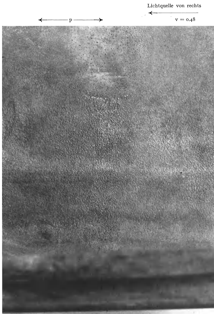
Bild 18. Saumrinne 2. Nach Abbeizen der Korrosionsprodukte. Bei Stelle p feine Durchlöcherungen
