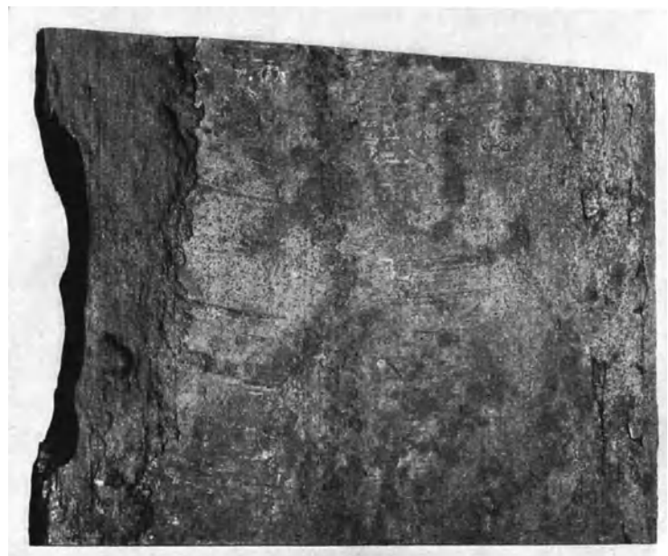
Bild 39. Angefressene Flanschkante des NP 32 bei Marke 32 in Bild 36 u. 37.
