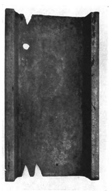
Bild 17. St 37 00 , Unterseite, nach 8 Jahren halb im Brackwasser (Emden)
