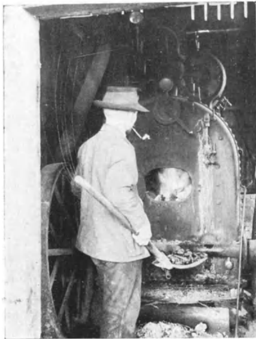
Dampferzeugung für die Desinfektionsmaschine.
