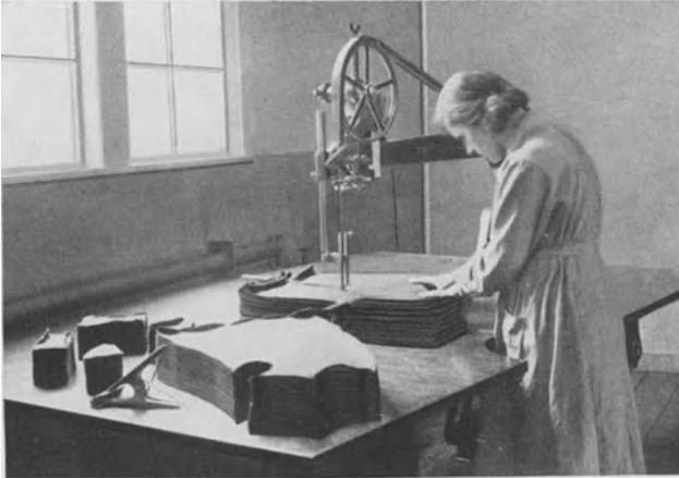
Abb. 7. Bandmesser-Zuschneidemaschine „Kuris“ (Krauss & Reichert, Stuttgart-Cannstadt).
