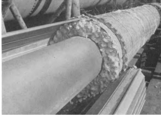
Abb. 35. Schlackenwollstopfdämmung mit Hilfe von Schablonen (Apur-Verfahren).
