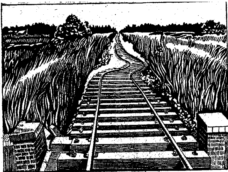
Рис. 68. Сдвиг рельсов при землетрясении.
