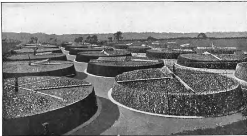
Abb. 105. Ansicht der Wilmersdorfer Tropfkörper (in Stahnsdorf bei Berlin).
