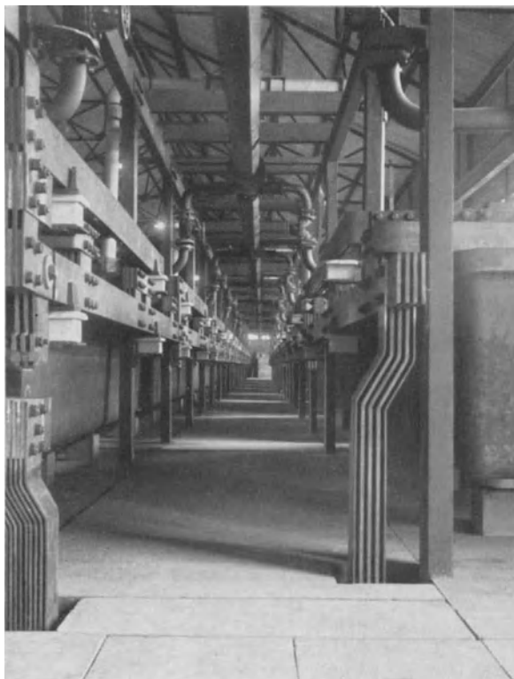
Abb. 92. Chloratanlage Chesterfield (erbaut von Krebs & Co.).
