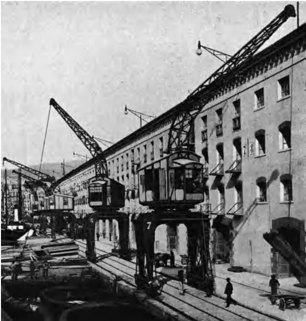
Fig. 163. Portal-Drehkrane, transportabel, Gleichstrom. Hafen Genua, Speicheranlage der Warehouses Company Ltd.
