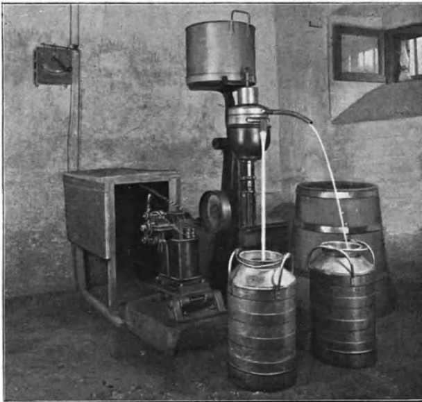
Fig. 212. Milchseparator, Gleichstrom.
