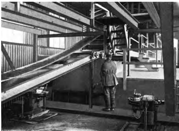
Fig. 156. Kohlen-Transportbänder, Gleichstrom. Centrale Luisenstrasse der Berliner Elektrizitäts-Werke.
