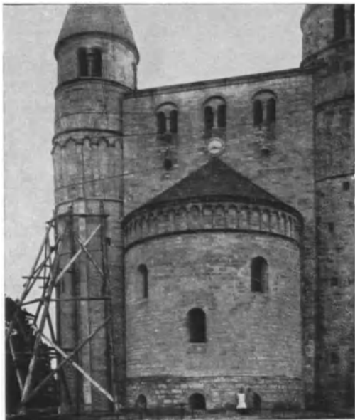
Abb. 50. Gernrode. Jetziger Abschluß des Glockenhauses der Westseite.
