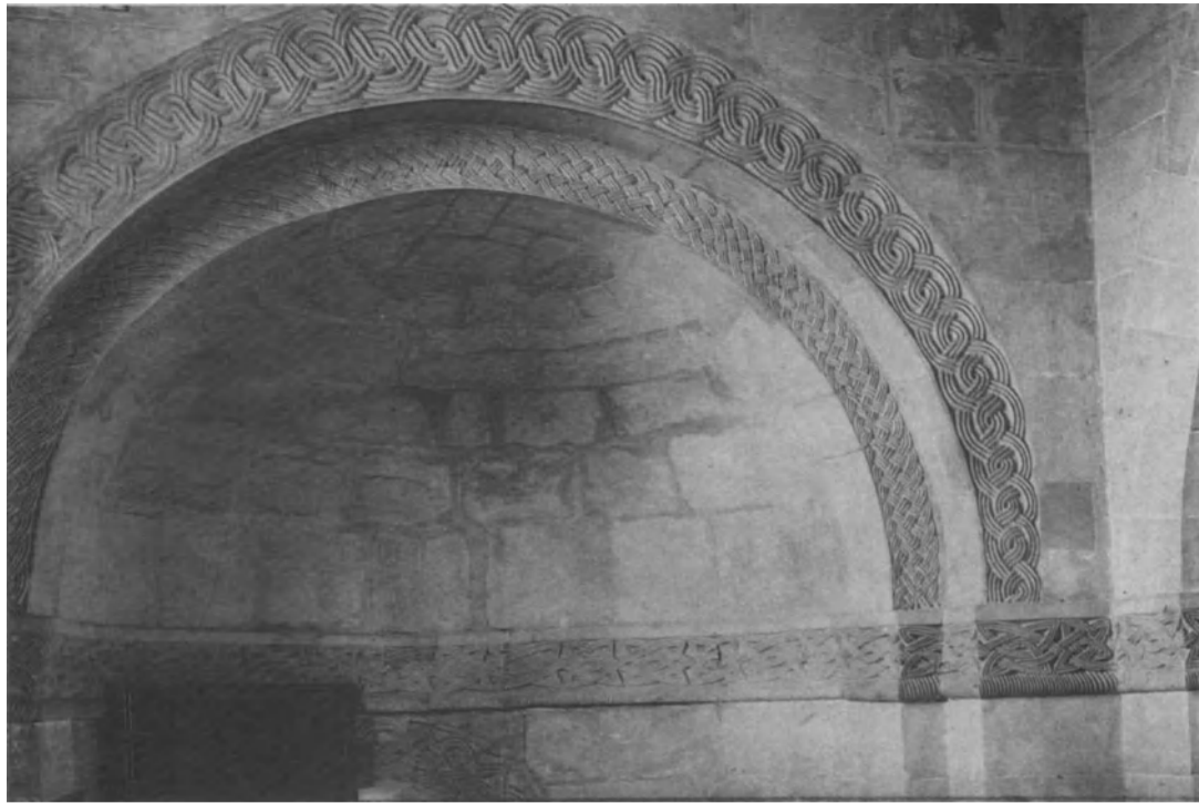
Abb. 6. Quedlinburg. Concha nördliches Querhaus.
