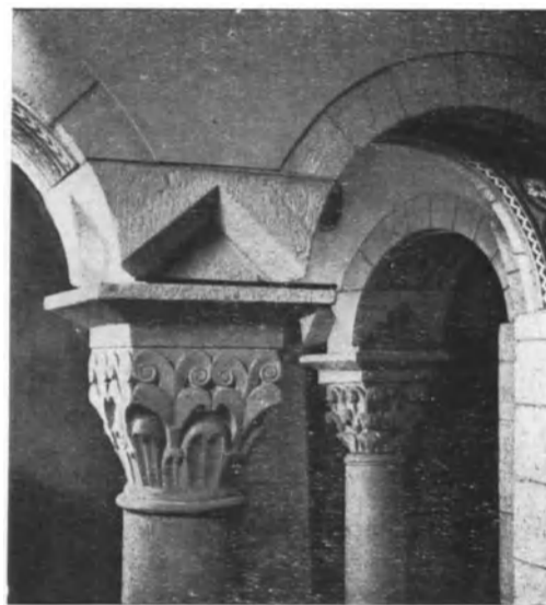
Abb. 51. Gernrode. Kapitell an der westlichen Querwand des südlichen Seitenschiffes.
