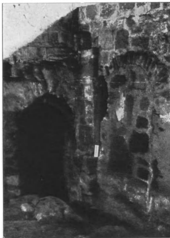
Abb. 12. Wipertikloster. Westwand. Nördliche Ecke.
