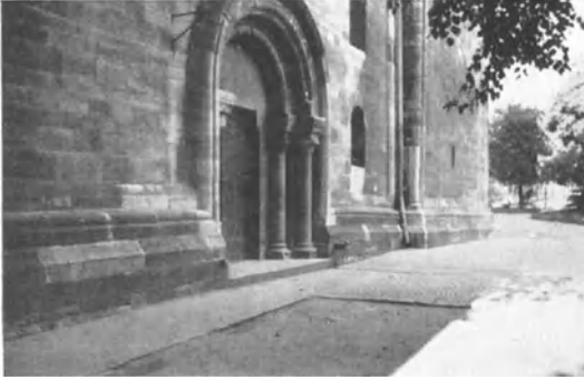
Abb. 123. Stärkere Setzung der Türme (Kirche in Hecklingen).
