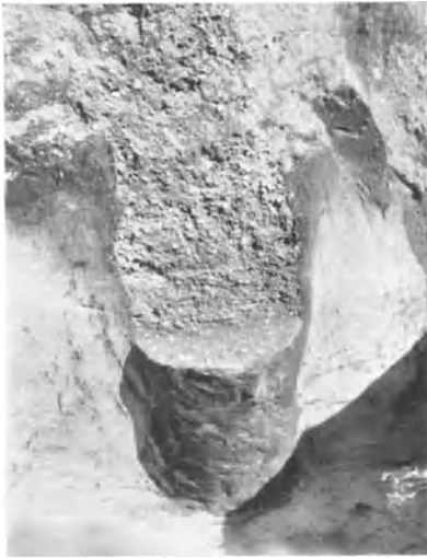
Abb. 67. Schnitt durch den Kopf eines Bodenverdichtungspfahles.
