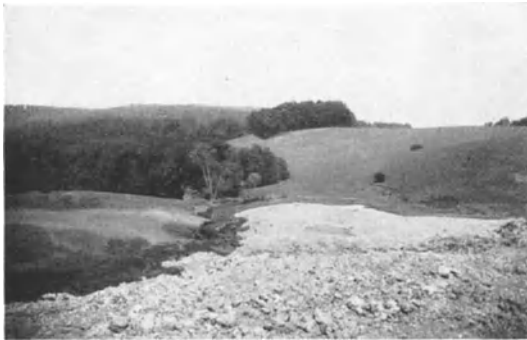
Abb. 55. Fließen von Keupermergel auf der Kippe.
