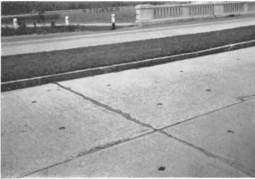
Abb. 86. Betonstraße mit Einpreßlöchern.
