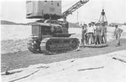
Abb. 76. Einbau einer Tondichtung.
