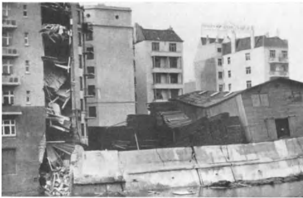
Abb. 148. Hauseinsturz in Hamburg.
