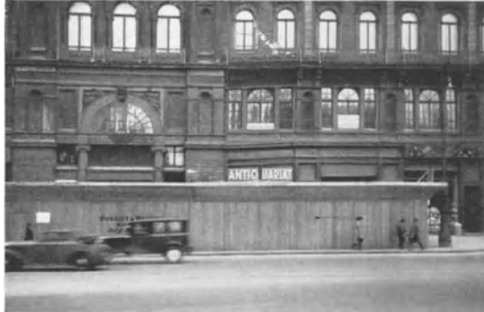
Abb. 125. Stärkere Setzung des über einem Moorgraben stehenden Mittelteils („Rotes Schloß“).
