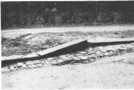
Abb. 75a und b. Bergbausenkung von Straßen.
