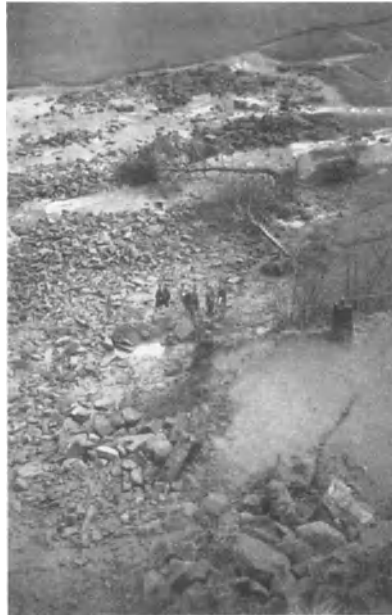
Abb. 106. Blick auf die in Abb. 105 im Querschnitt dargestellte Rutschung.
