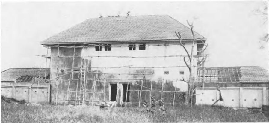
Abb. 134. Abreißen leichterer Anbauten vom Hauptgebäude infolge geringerer Setzung.
