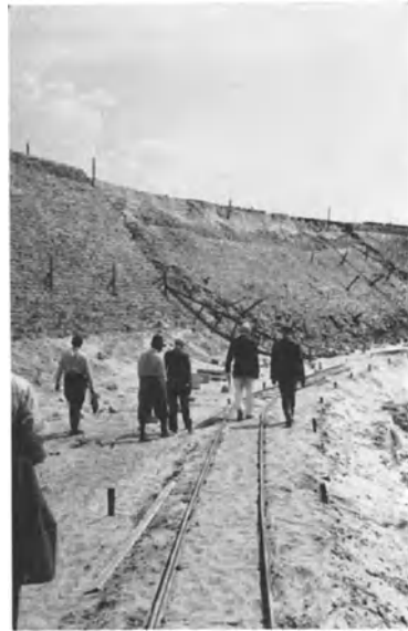
Abb. 53. Rutschung im Sand bei zu steiler Böschung (1:1).
