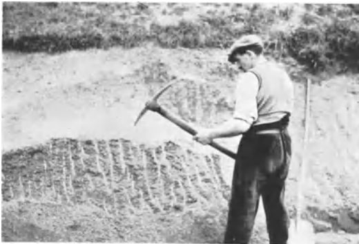
Abb. 5. Lösen von „Bergkies“.
