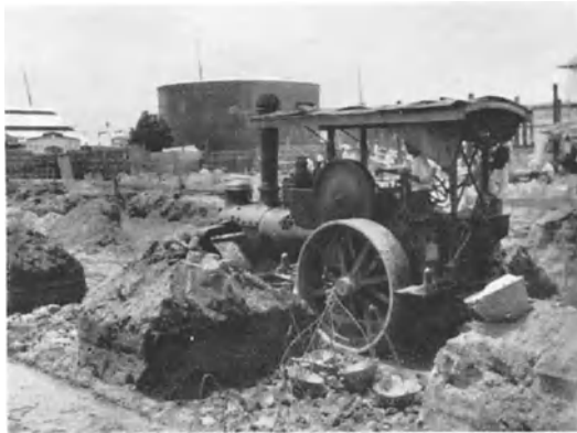
Abb. 139. Eine 8-t-Walze beim Einwalzen einer Lage Kalkschotter unter den Fundamenten eines Kaischuppens (Soerabaya, Java).
