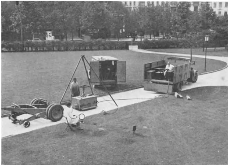
Abb. 46. Aufstellung der Geräte für die dynamische Bodenuntersuchung.
