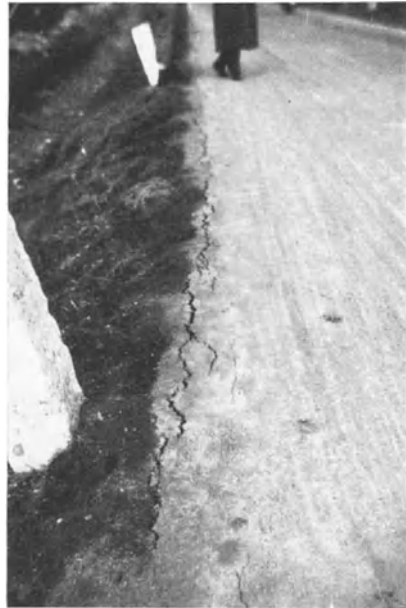
Abb. 104. Einzelheit zu 103, Rißbildung am Rand der Decke.
