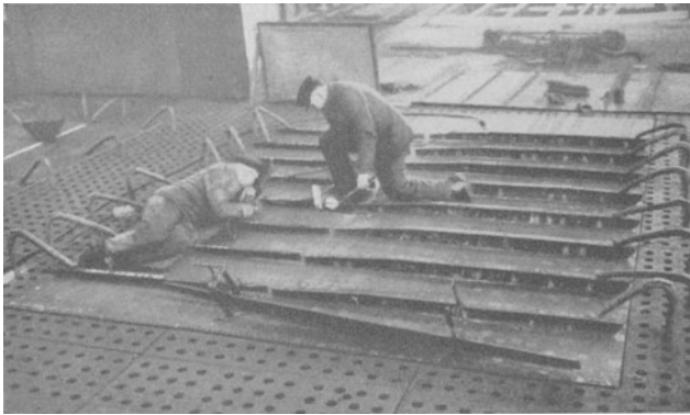
Abb. 284. Schweißen eines Schotts auf der Spannplatte.
