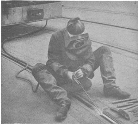
Abb. 147. Schweißer mit Schweißgerät (beim Schienen-aufschweißen).
