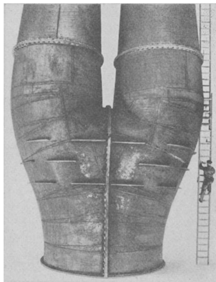
Abb. 213. Hosenrohrformstück für eine Turbine.
