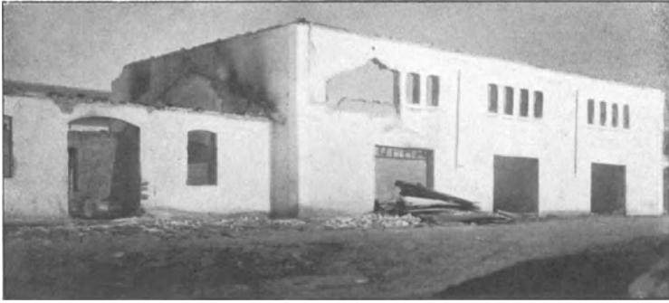
Abb. 69. In die Luft gesprengtes Magazin.
