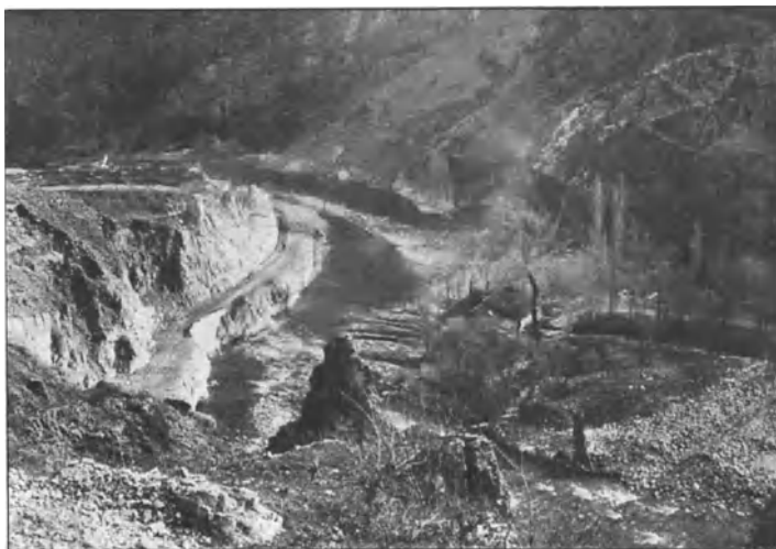
Abb. 40. Landschaft an der Eisenbahnstrecke Plewna—Sofia (Iskerdurchbruch).
