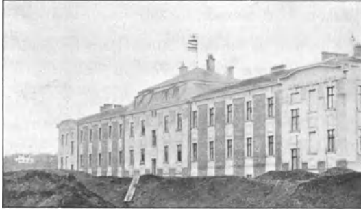
Abb. 2. Arbeiterkaserne der Zuckerfabrik, in deren östlichem Flügel das Lazarett untergebracht war.
