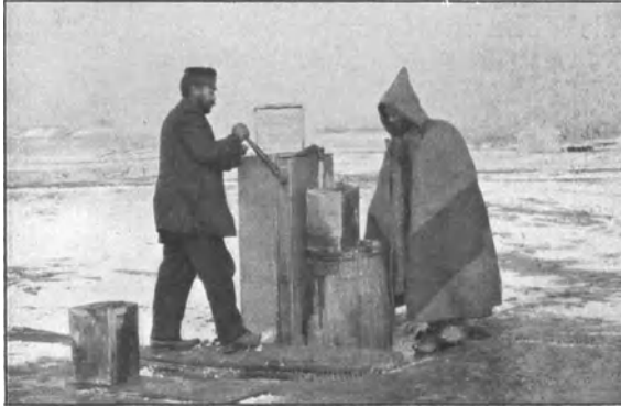
Abb. 43. Grundwasser-Brunnen des Lazarettes. Als Eimer dienen alte Petroleumbüchsen.
