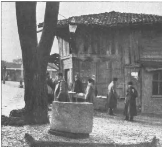
Abb. 30. Alter türkischer offener Brunnen in Dimotika, der durch Straßenschmutz verunreinigt werden konnte.
