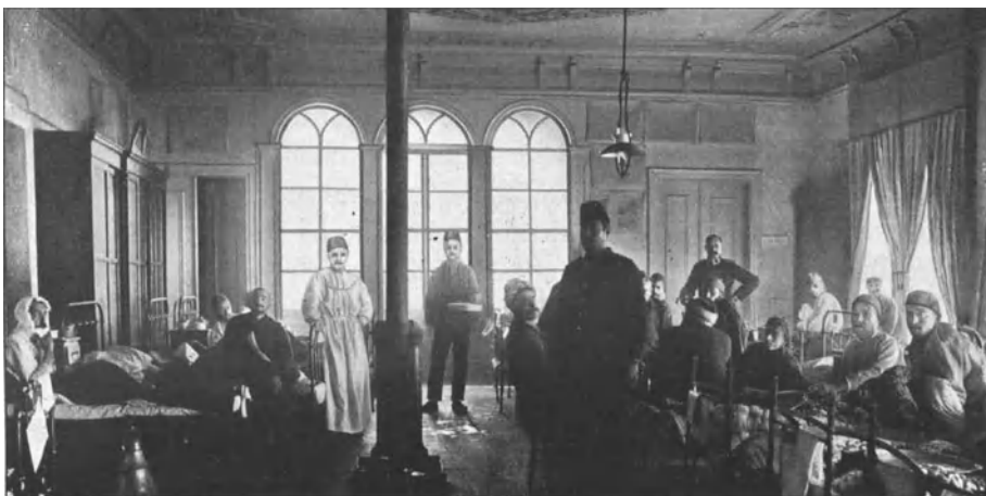
Abb. 6. Krankensaal in der Veterinärschule.
