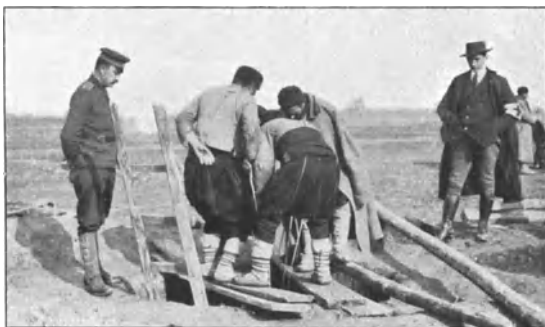
Abb. 42. Das Graben des Grundwasserbrunnens im Etappenlazarett.
