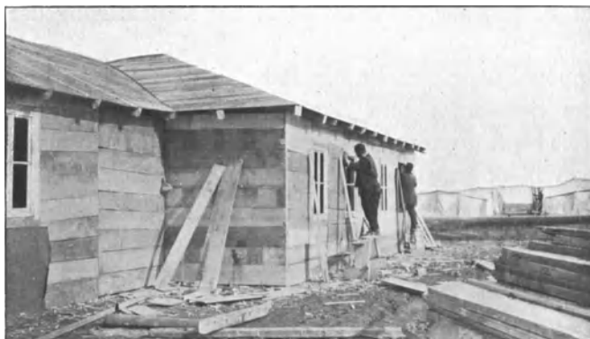
Abb. 34. Der Bau unserer Baracke.
