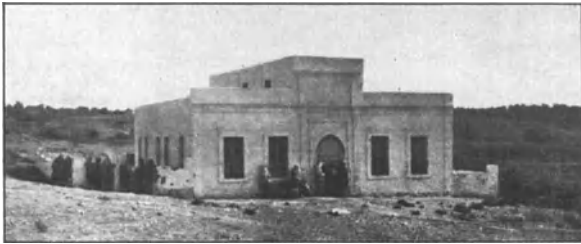
Abb. 2. Poliklinik und Operationshaus, das Schulhaus von Gharian.
