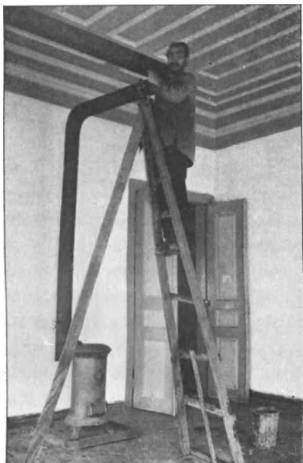
Abb. 3. Setzen eines Ofens durch türkischen Handwerker.
