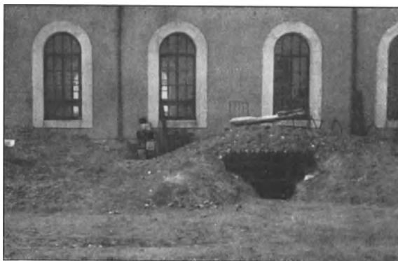
Abb. 78. Eingang zu einem bombensicheren Unterstande im Hofe des Hospitals.
