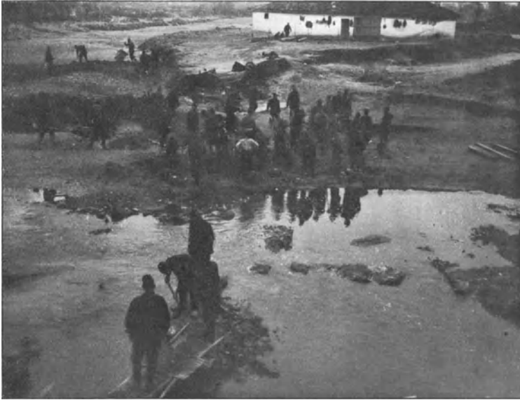
Abb. 25. Türkische Gefangene bei Erdarbeiten an der Maritza.
