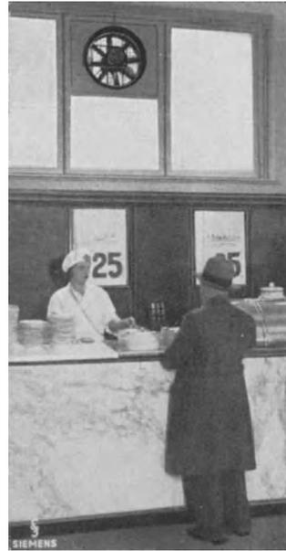
Abb. 32. Eingebauter Ablüfter.
