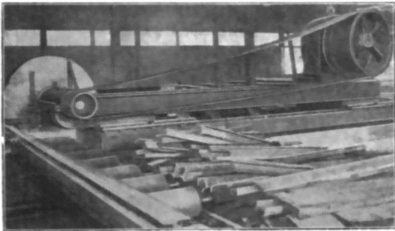
Bild 258. Schnellreißsäge mit Riemenantrieb und Druckluftvorschub; Henry Ferguson, St. Louis, 1905.
