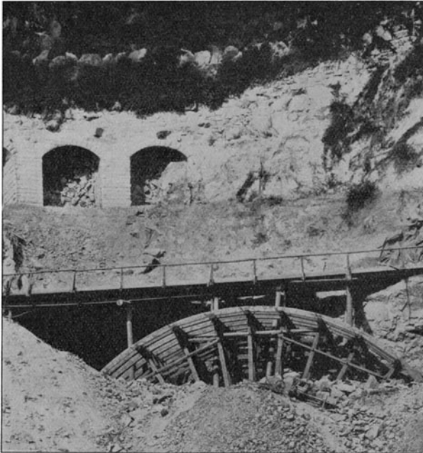
Abb. 52. Das Lehrgerüst der Rappenschluchtbrücke. Oben die Landstraße und deren neue Trockenmauerunterfangung.
