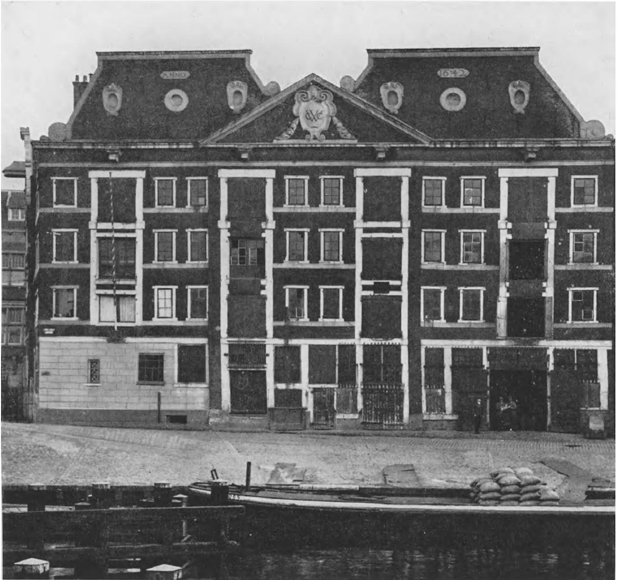
54. Das „West-Indisch Huis“ im heutigen Zustande. Frontansicht am Kalkmarkt
