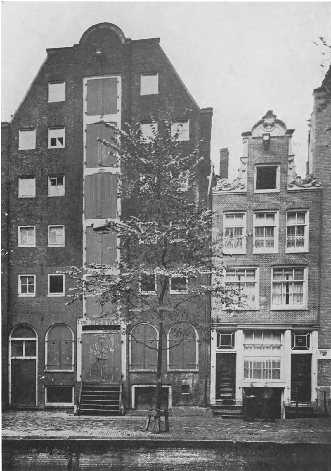
78. Lagerhaus „De Sperwer“, Kromboomsloot 33
