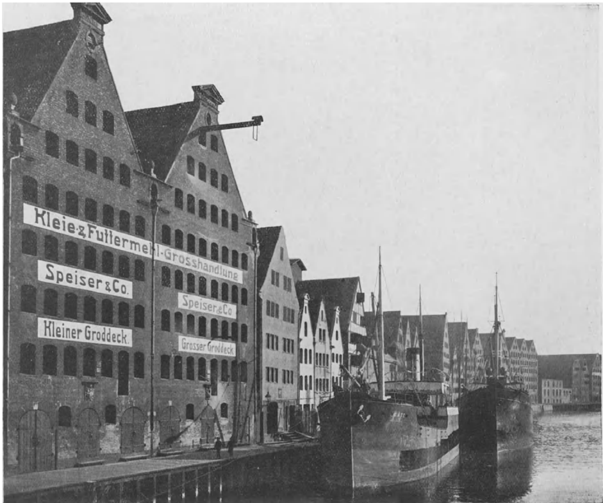
127. Speicher an der Mottlau
