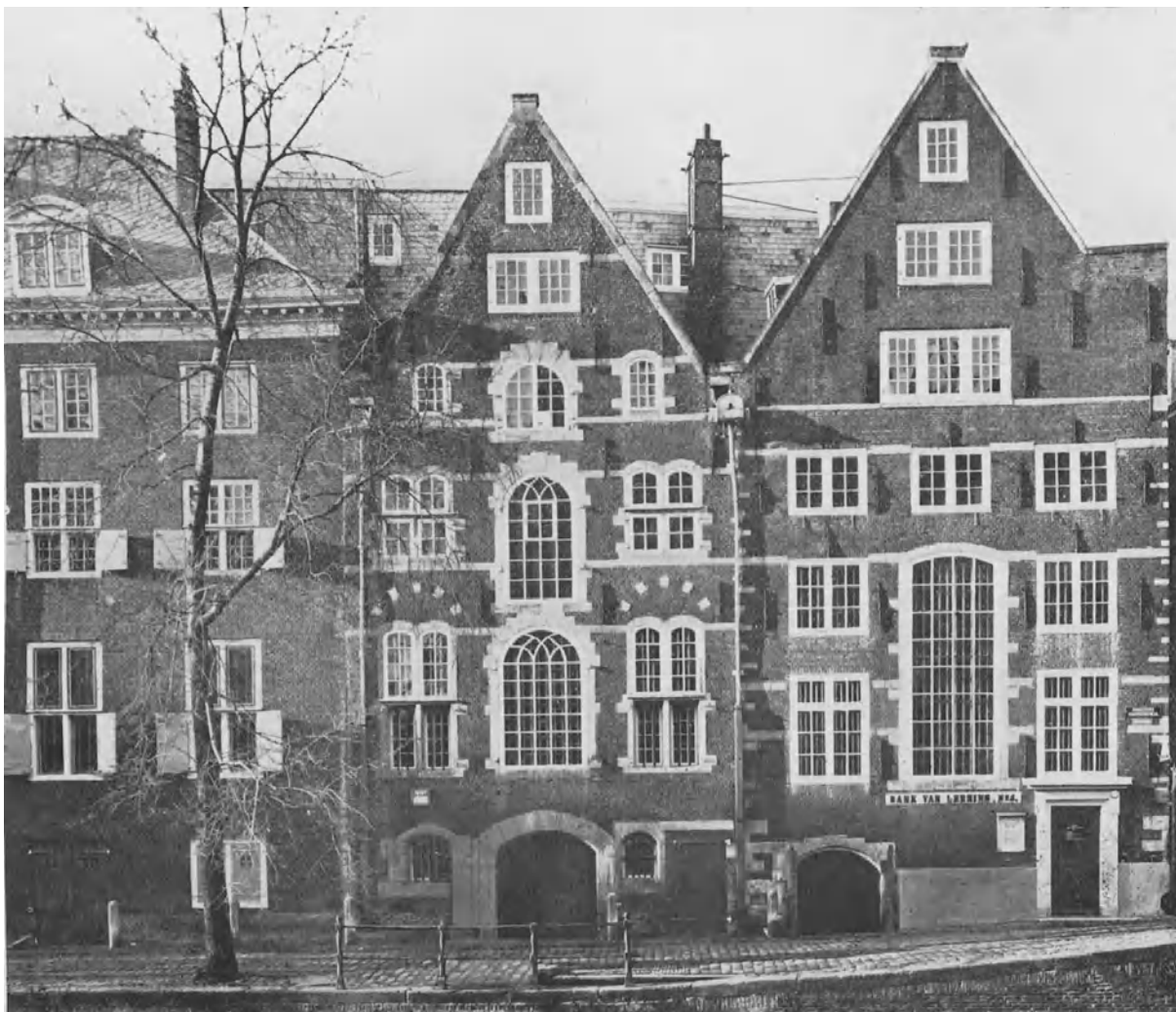
23. Die Fassaden der Bank van Leening im heutigen Zustande. O.-Z. Voorburgwal 300
