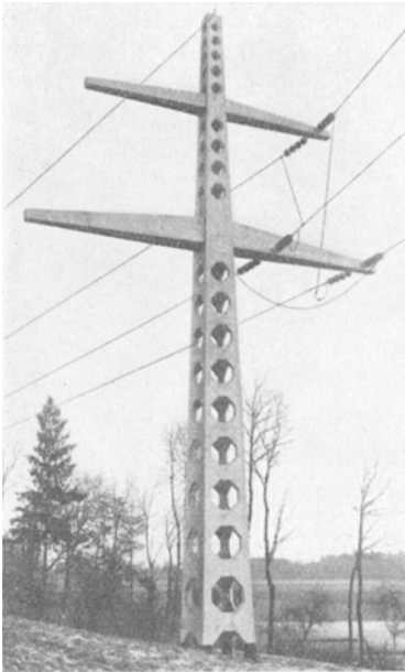
Abb. 106/8. Eisenbetonmast der 110 kV-Leitung Wegscheid-Timmelkamm (Winkelmast mit Verdrillung). Kupfer 3 \times 120 \text{ mm}^2 , 14,3 \text{ } \varnothing , Erdseil: Stahl 70 \text{ mm}^2 , 10,8 \text{ } \varnothing , mittlere Spannweite 230 m (Ob.-Österr: Kraftwerke).
