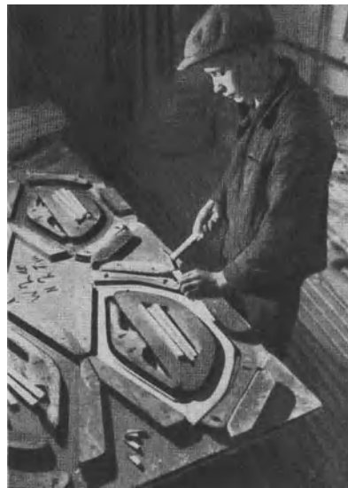
Abb. 121. Herstellung von Spanten.
