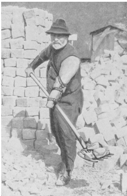
Abb. 472. Primitive Arbeitsprothese, von dem Amputierten selber konstruiert.
