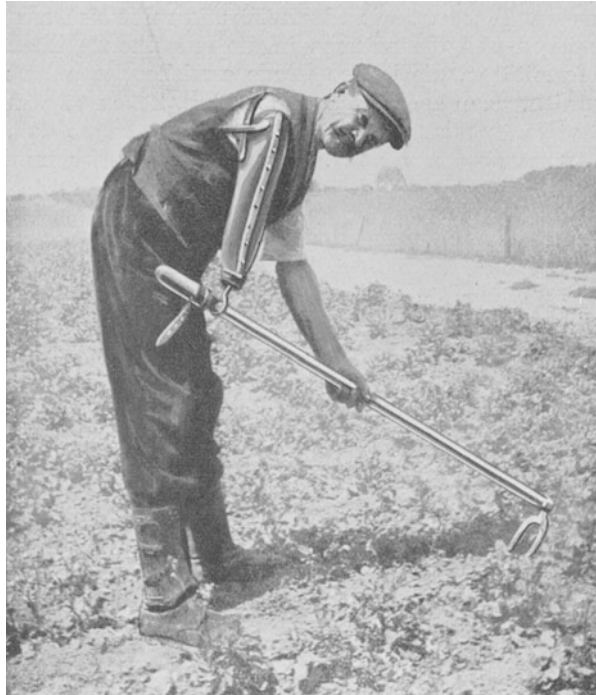
Abb. 473. Primitive Arbeitsprothese, von dem Amputierten selber konstruiert.
