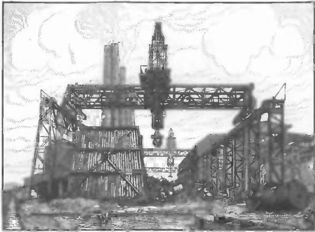
Abb. 84. Magnetkrananlage auf einem Schrottplatz.
