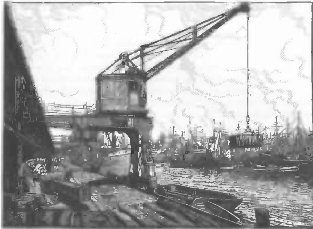
Abb. 102. Portalkrananlage im Hamburger Hafen.
