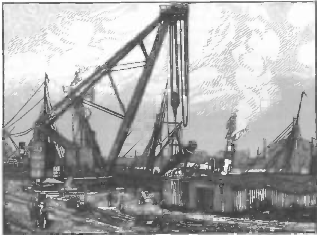
Abb. 77. Schwerlastkran von 150 t in Hamburg auf dem Grasbrook. Erbaut im Jahre 1887.
