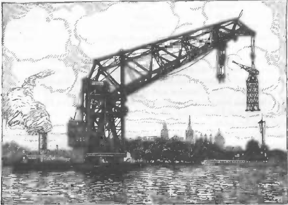
Abb. 167. Der 275t Schwimmdrehkran in Wilhelmshaven versetzt einen Hellingsturmdrehkran.
