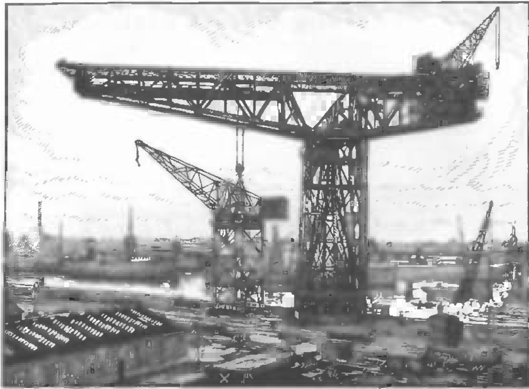
Abb. 116. 250 t Hammerwippkran auf der Werft von Blohm & Voß, Hamburg.
