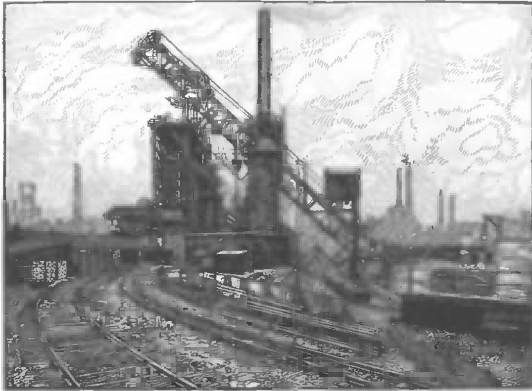
Abb. 118. Hochofenschrägaufzug System Stähler © Demag.
