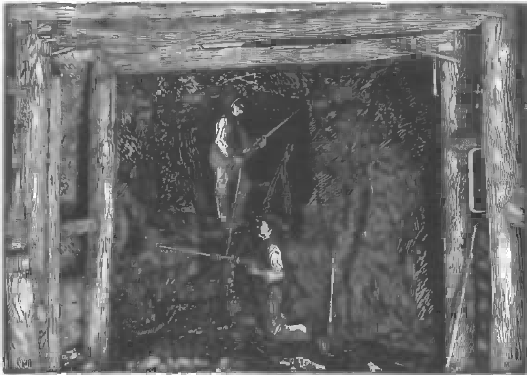
Abb. 30. Stollenvortrieb mit Preßluftbohrhämern.
