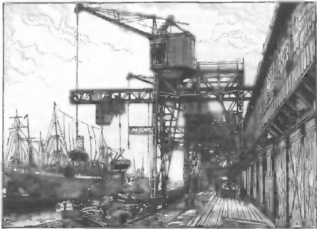
Abb. 128. Doppelkran-Anlage im Hamburger Hafen.
